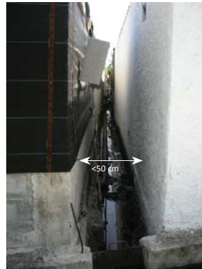
Invernaderos e instalaciones asociadas sin retranqueo.
