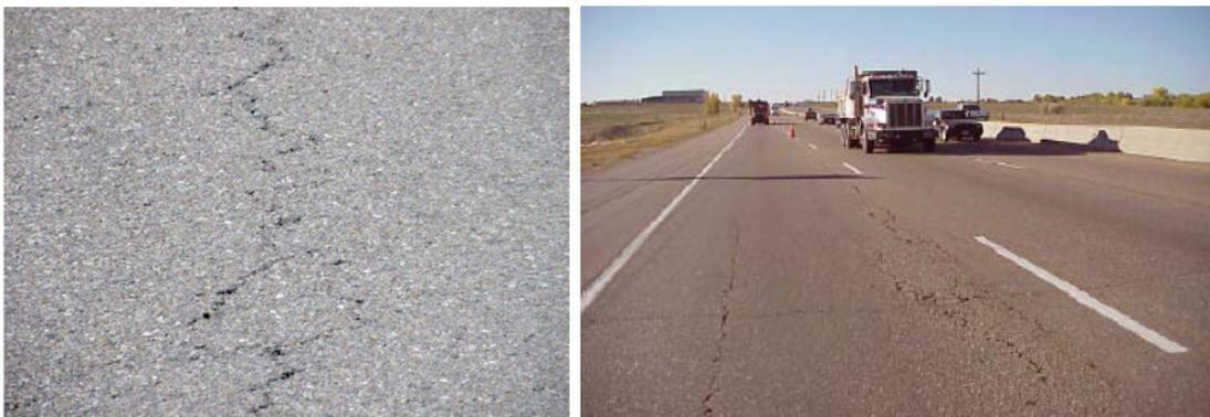
Figura 13. Aspecto de la fisuración descendente en la superficie de un firme (Proyecto Fenix 2010).
