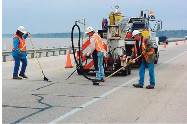
Figura 19. Sellado de fisuras mediante ponteoado. (Yildirim et al. 2006)
