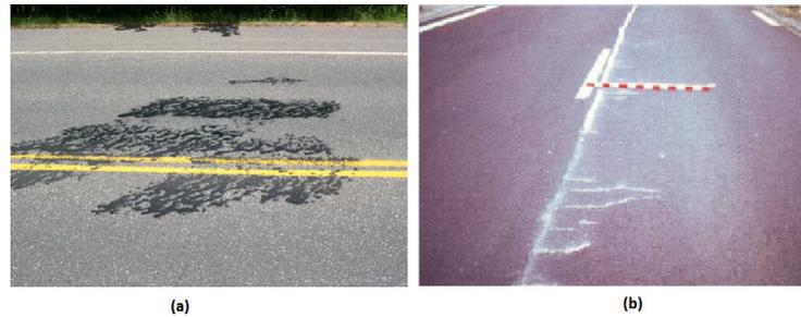
Figura 4. Patologías de los firmes II: movimientos de material. (LCPC 1998)
