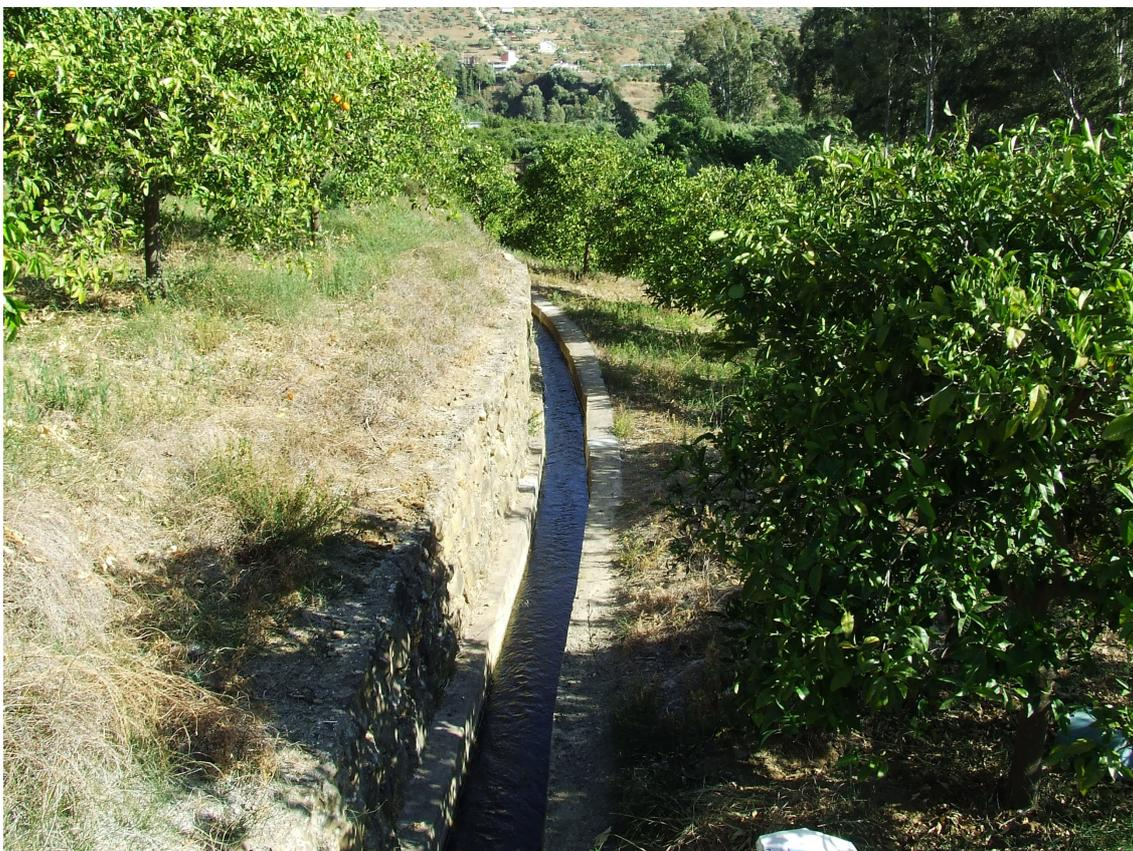
IMAGEN 25: Acequia de la margen derecha del río Grande, en un tramo descubierto. Esta acequia se extiende por varios kilómetros hasta llegar al límite con Guaro.
