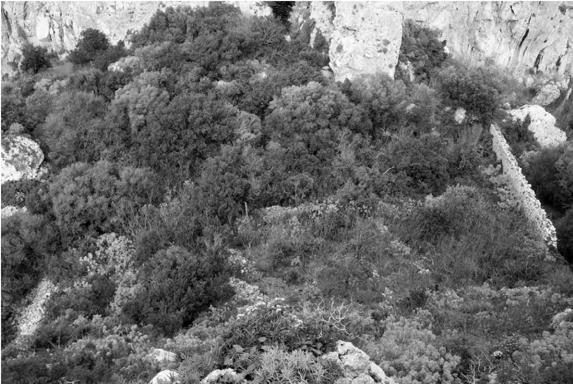
Fig. 81. Muro di sbarramento (UT 06) costruito alle spalle e a nord del castello, tra il pizzo roccioso e la montagna.
