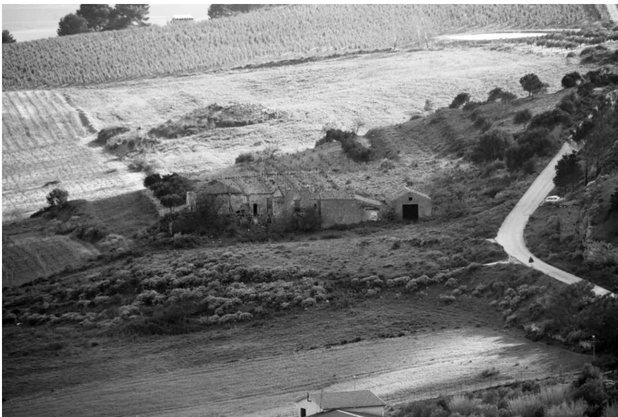
Fig. 123. Baglio Bumbuluni visto da nord.
