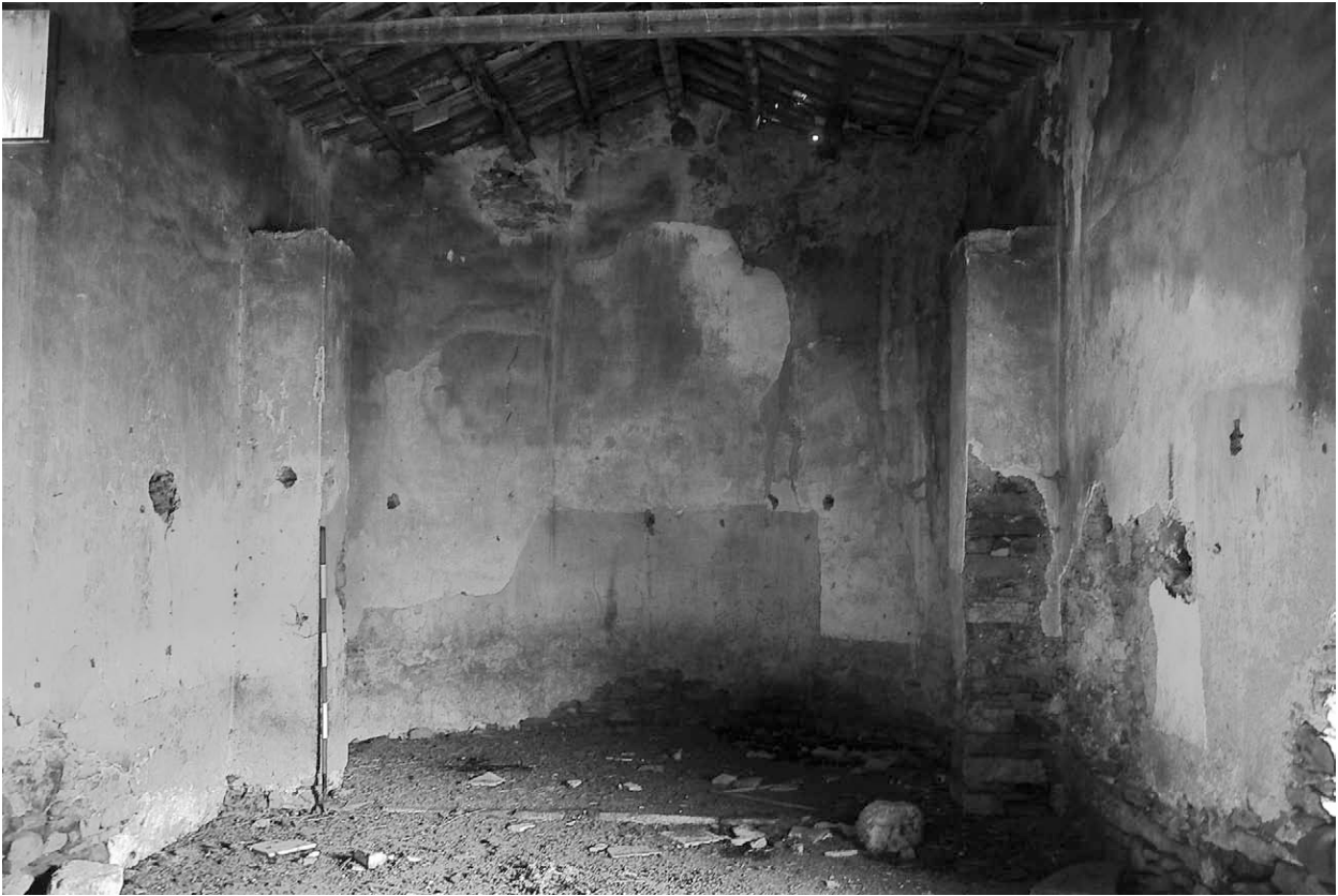
Fig. 164. Vista dell'abside interno della chiesa del Baglio Fontana.
