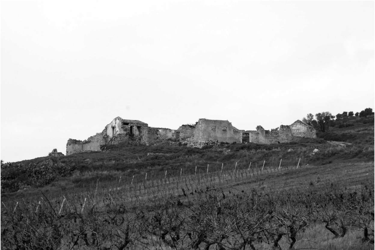
Fig. 132. Baglio Ragoleo visto da est.
