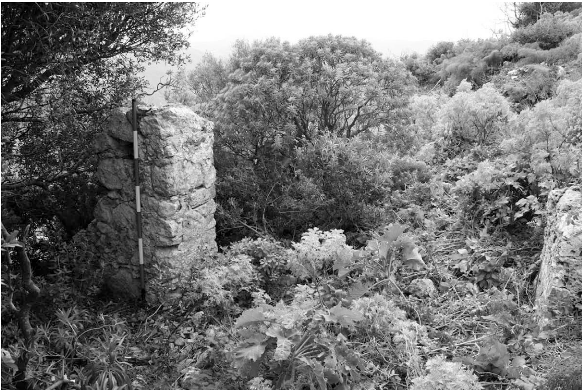
Fig. 78. Stipite della struttura che abbiamo interpretato come porta (UT 03) di accesso alla torre.
