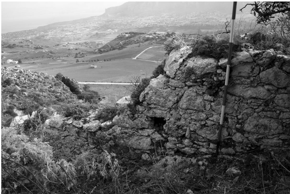
Fig. 84. Dettaglio di un lacerto del muro di cinta che cinge il perimetro dello sperone roccioso. Si noti la tecnica con bozze di calcare di pietre di grandi dimensioni, apparecchiate su corsi irregolari e inzeppate con pietre di piccole dimensioni. La malta di calce è molto dura e tenace.
