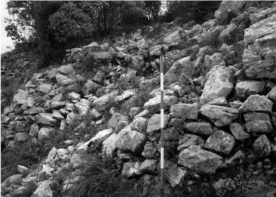
Fig. 51. Porta di accesso parzialmente crollata identificata sulle pendici orientali del pizzo roccioso dell'UT 04.
