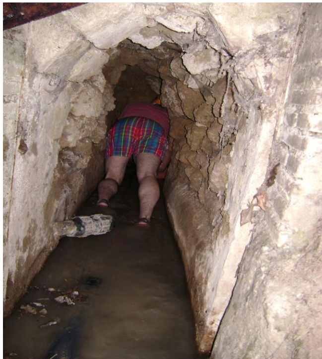
Mina de la Quinta de Jaula inundada de agua
