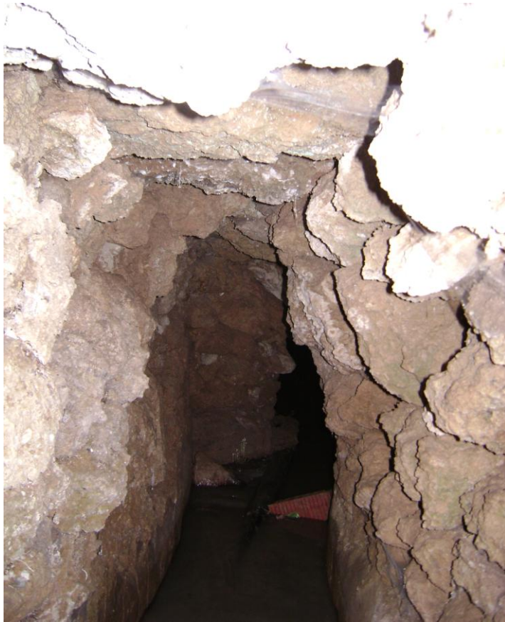
Tramo inicial de la Mina de la Quinta de Jaula
