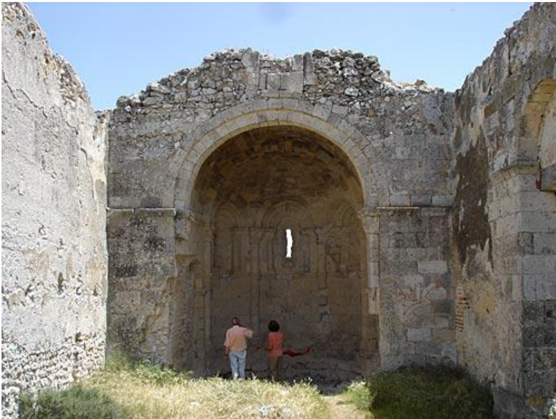
Ilustración 03. Imagen de la nave, estado actual.
