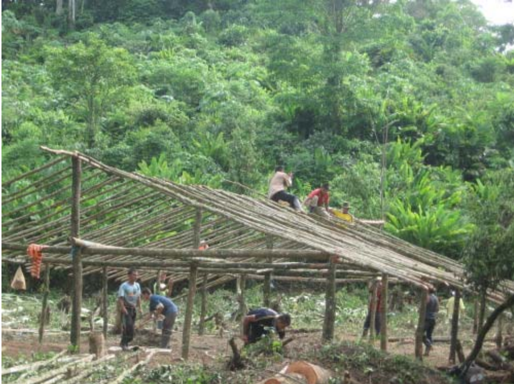
Foto 6. Construyendo casas en El Refugio, territorio de paz en el Catatumbo
