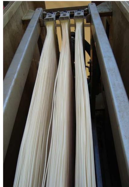
**Fig. A.3. Detalle del tren de membranas con tres módulos.**
