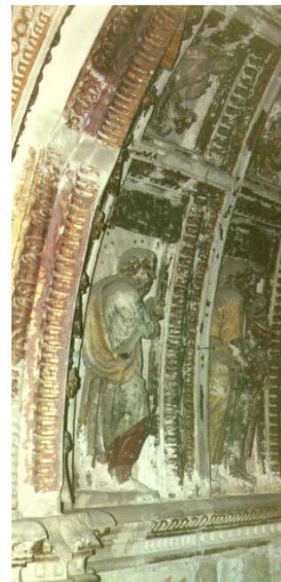
Figura 6.3. Desplazamiento del arco de la bóveda del interior de la Iglesia de San Jerónimo.
