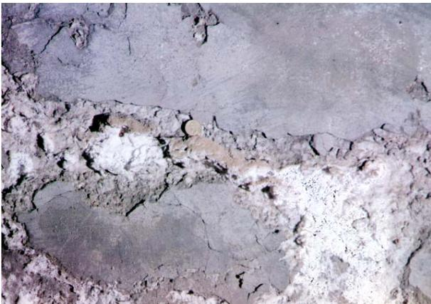
Figura 6.6. A) Fotografía superior. Desarrollo de sales hasta una altura superior a 3 m en la pared S de la habitación E de la Iglesia de San Jerónimo. B) Fotografía inferior. Detalle de la morfología de las sales y su acción destructiva en los revestimientos.
