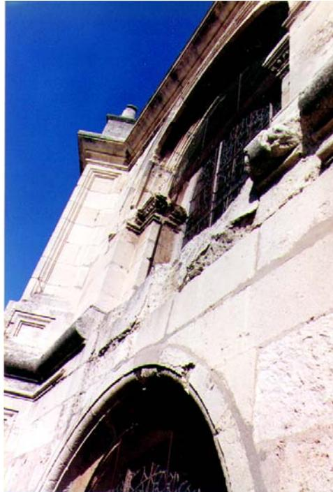
*Figura. 6.1. Pérdida de relieve y desprendimiento de elementos decorativos en la fachada SW de la Iglesia de San Jerónimo. Detalle de alveolización y descohesión selectiva en sillares contiguos.*
