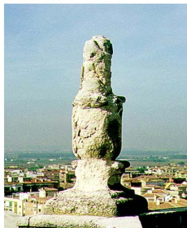
*Figura 6.5. A) Fotografía izquierda. Pérdida de elementos planares ("case hardening") en sillares de calcarenita en la fachada W de la Iglesia. B) Fotografía derecha. Desplacado en un pináculo situado en el cimborrio de la Iglesia ("contour scale").*
