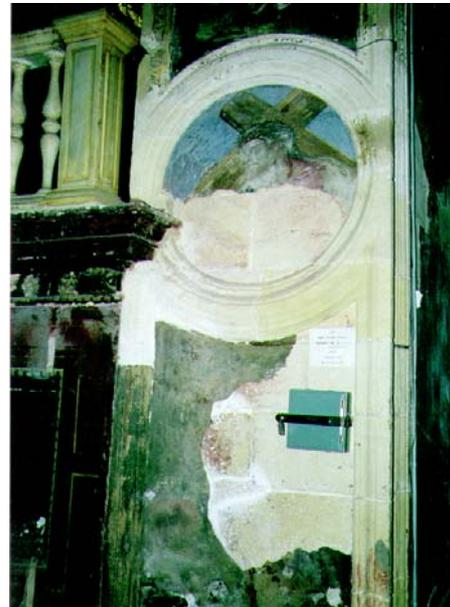
Figura 6.7. Desprendimiento del mortero de revestimiento con pintura mural en el acceso a la habitación W. Obsérvese las subeflorescencias entre dicho revestimiento y la calcarenita.
