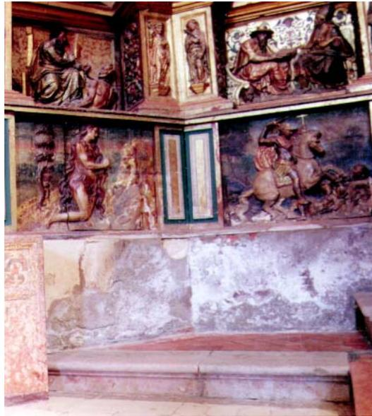
*Figura 6.9. Superposición de revestimientos de diferente naturaleza y desprendimiento de los mismos con subeflorescencias y eflorescencias. Altar de la Iglesia de San Jerónimo.*
