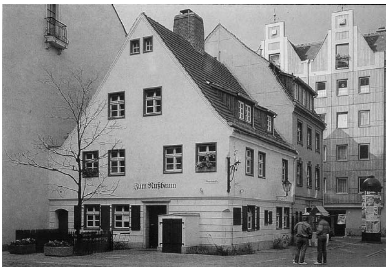
Fig. 33 y 34. Arriba, el popular restaurante “Nussbaum” antes de la guerra; abajo, reconstrucción de los años 70. Las estructuras originales leñosas han sido sustituidas por modernas fábricas de hormigón armado y ladrillo; el torpe formalismo anacrónico hace difícilmente creíble esta construcción.
