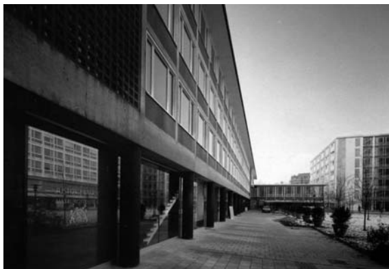
Fig. 47. Vistas del estado actual. Los cuerpos abiertos generan patios en sus relaciones volumétricas. El conjunto es utilizado actualmente como espacio multifuncional de oficinas, comercios, y apartamentos.
