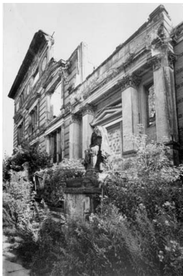
Fig. 37 y 38. Izda., fachada norte del Martin-Gropius-Bau con los daños de guerra. La destrucción fue muy acusada en este edificio, la planta superior se perdió prácticamente por completo; dcha., interior del edificio reconstruido. Al igual que con la Schauspielhaus , los lujosos interiores fueron miméticamente reproducidos, así como sus fachadas, hasta en sus últimos detalles.
