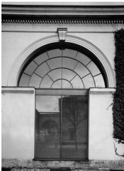
Fig. 39. Los huecos que dan al patio se ampliaron desde los lunetos originales hasta el nivel del suelo. La relación interior-externo se acrecentó.
