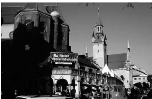
Fig. 4 y 5. La torre del Alterthaus (arriba) se perdió completamente en la guerra. La reconstrucción (abajo) nos recuerda aproximadamente la imagen original. Ésta se hizo empleando materiales modernos como el hormigón armado, que le confieren una falsa apariencia de originalidad.
