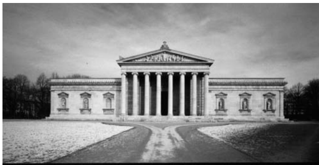
Fig. 40 y 41. Fachada de la Gliptoteca (arriba) y detalle de su cornisa (abajo), estado actual. Las partes derruidas se reconstruyeron bajo el concepto de “sólido capaz”, la decoración escultórica de la fachada no fue recuperada, así como la acrótera del frontón.
