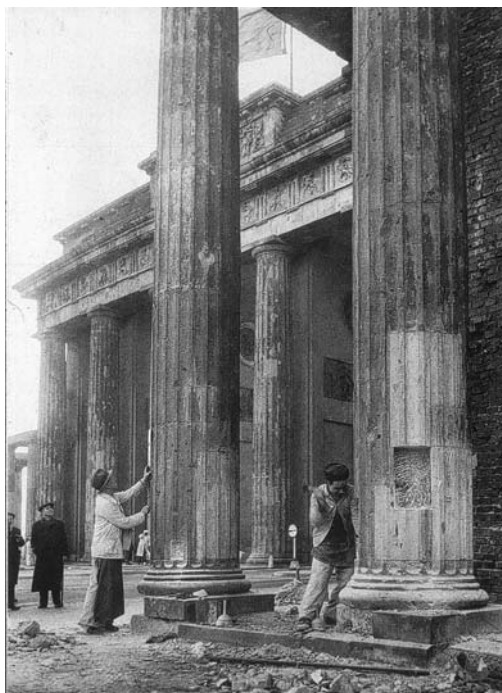
Fig. 8. Vista del Brandenburger tor en 1957, durante los trabajos de reconstrucción. Fue necesario reconstruir por completo el ala meridional, totalmente destruida, y gran parte del ala septentrional; el cuerpo central presentaba igualmente serios daños.
