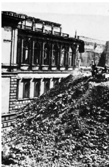
Fig. 10. La Alte Pinakothek de Munich en 1945. Una montaña de escombros provenientes del centro de Munich se apilaban en los parterres de la fachada sur de la Pinacoteca. La cadena de vagonetas instalada provisionalmente para el desescombro finalizaba en ellos, apoyando el talud de escombros en las fachadas del museo.
