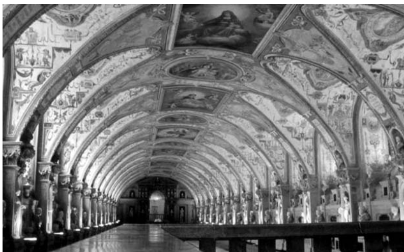
Fig. 8. El Antiquarium tras la reconstrucción, estado actual. Se recuperó de manera idéntica toda la decoración original siguiendo el modelo existente y fotografías de época. Estructuralmente las bóvedas se reconstruyeron en hormigón armado.
