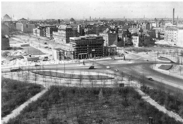
Fig. 8. Vista del Brandenburger tor en 1957, durante los trabajos de reconstrucción. Fue necesario reconstruir por completo el ala meridional, totalmente destruida, y gran parte del ala septentrional; el cuerpo central presentaba igualmente serios daños.
