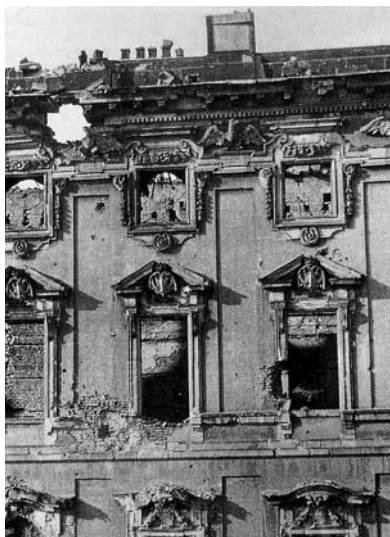
Fig. 25 y 26. Izda., Fachada meridional del Stadtschloß con los daños de guerra, solamente el 50% del conjunto presentaba daños considerables. Abajo, Operaciones de derribo del Stadtschloß en 1951.
