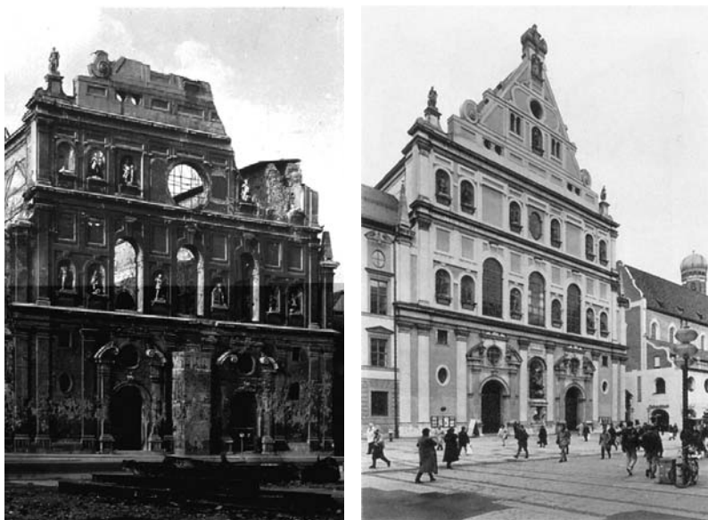
Fig. 2 y 3. La Michaelkirche destruida en 1945 la reconstrucción de 1953 sigue el proceso de “identidad formal”. Siguiendo las trazas de las partes no demolidas, fue recuperada completamente, hasta el mínimo detalle.
