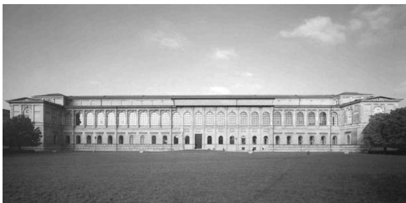
Fig. 20. La Alte Pinakothek en su estado actual, la reconstrucción se integra en el conjunto manifestando las situaciones de sutura que marcan el límite entre parte original y parte reconstruida.
