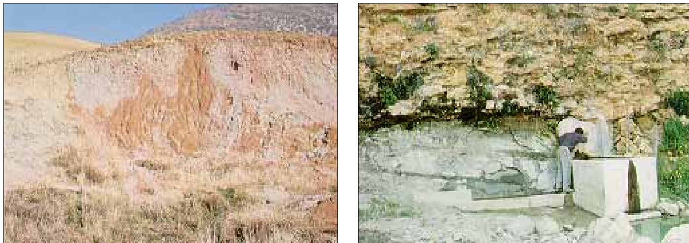
FIG. 7.2. a. Vista de un talud de arcilla versicolor (izda.). b. Arcillas del Tejar. RA010 (drcha.)
