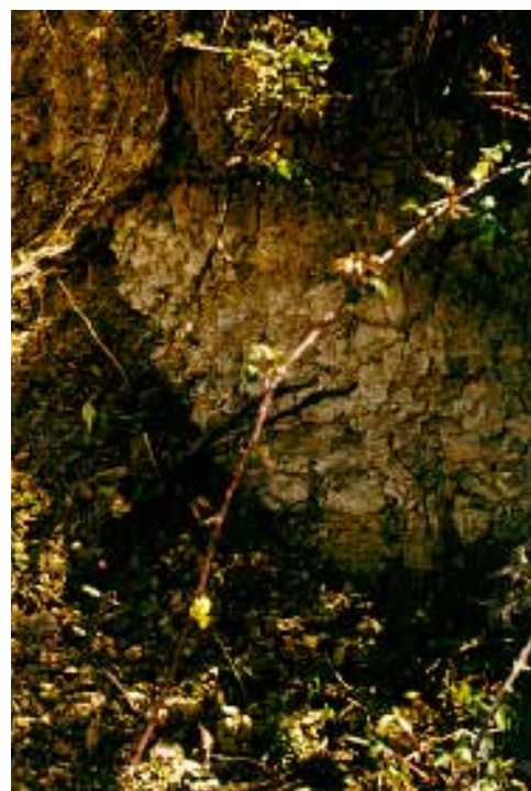
FIG. 7.9. Vista de un talud con arcillas miocenas
