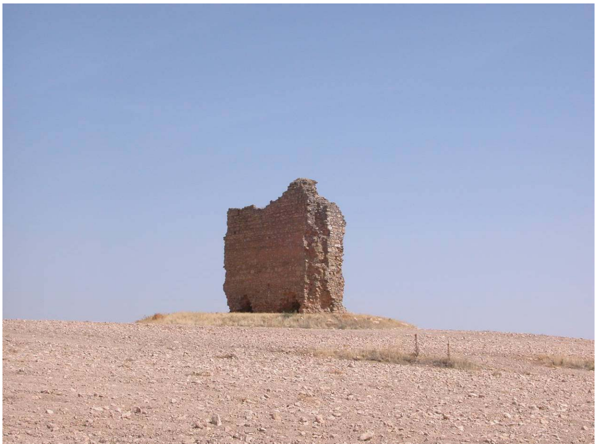
Ilustración 54: Restos de la Torre de Moratalaz
