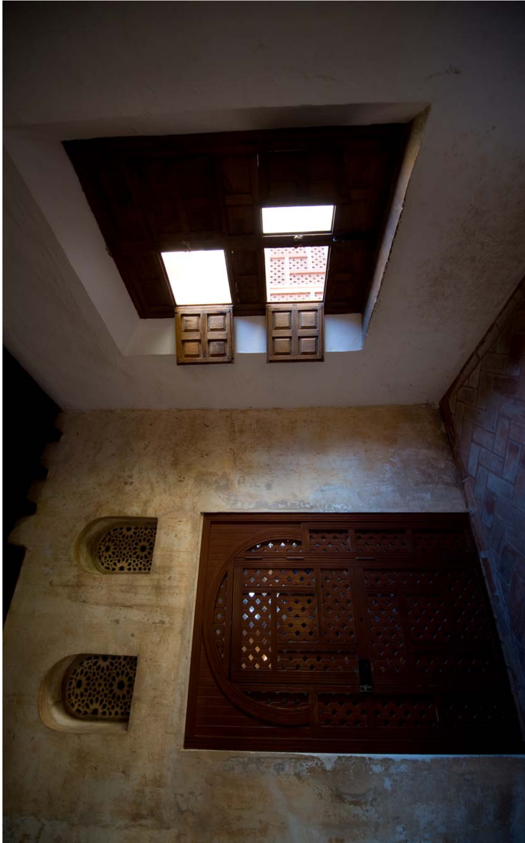
LÁMINA 114: ALHAMÍ DEL SALÓN DEL TRONO CONVERTIDO EN PUERTA DE COMUNICACIÓN CON LOS CUARTOS NUEVOS. FOTOS: FIESTAS MORENO, M.
