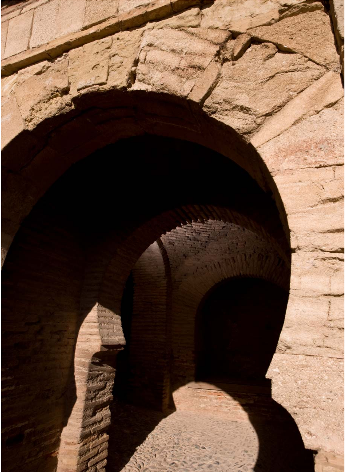
LÁMINA 23: DETALLE DE LA BÓVEDA SIN CIMBRA DE LA PUERTA DE GIAFAR. FOTOS: FIESTAS MORENO, M.
