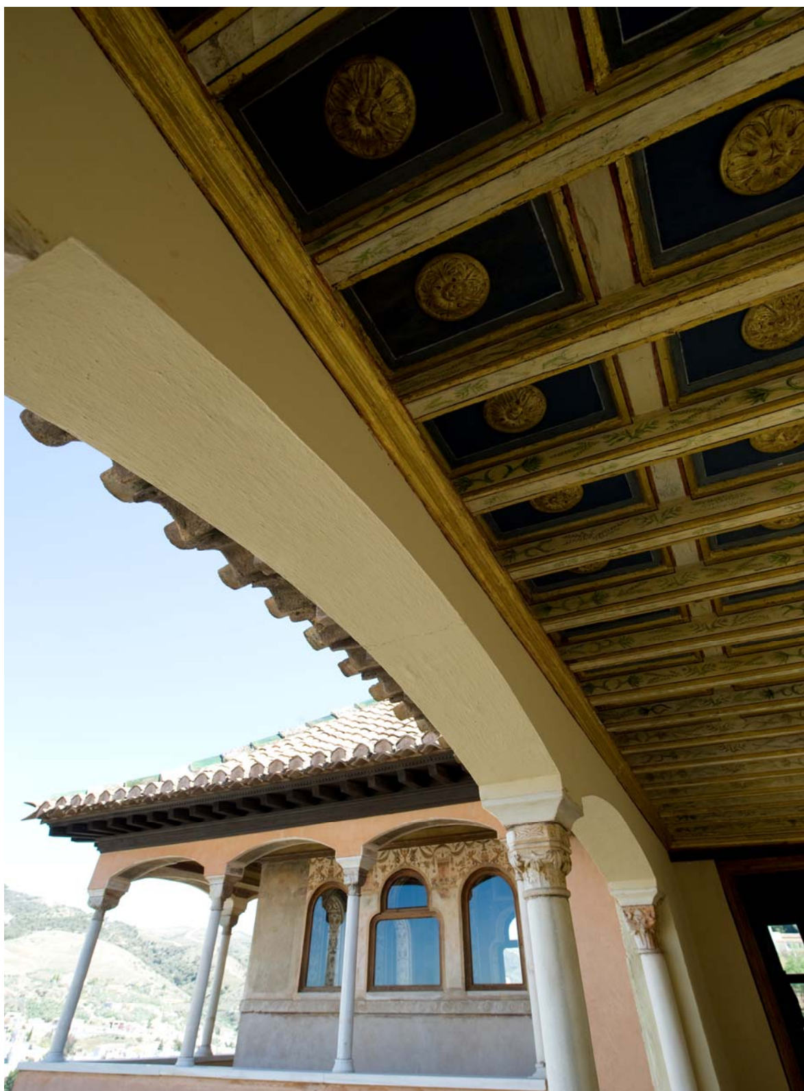
LÁMINA 107: DETALLE DEL ARTESONADO DEL PUENTECILLO QUE UNE LOS CUARTOS NUEVOS CON EL PEINADOR. FOTOS: FIESTAS MORENO, M.
