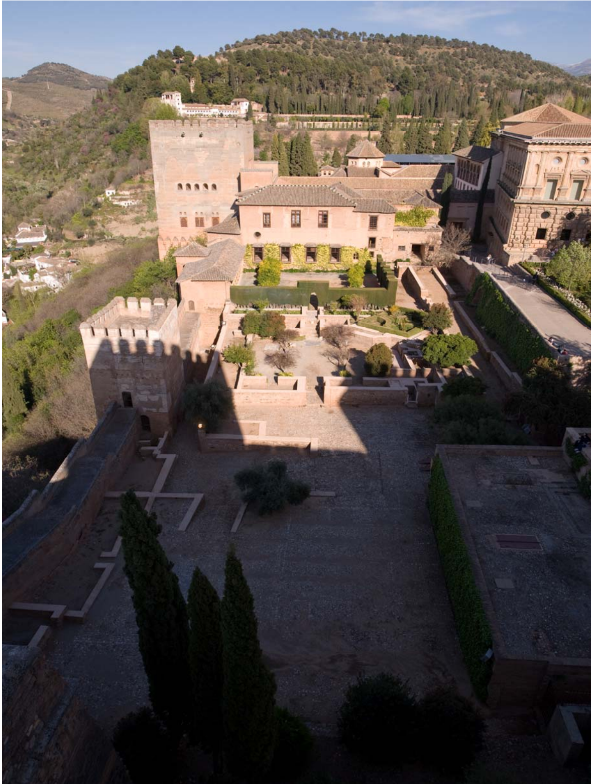
LÁMINA 26: VISTA DE CONJUNTO DEL PALACIO DE COMARES DESDE LA TORRE DEL HOMENAJE. PRIMERAS ESTANCIAS ADMINISTRATIVAS. FOTOS: FIESTAS MORENO, M.
