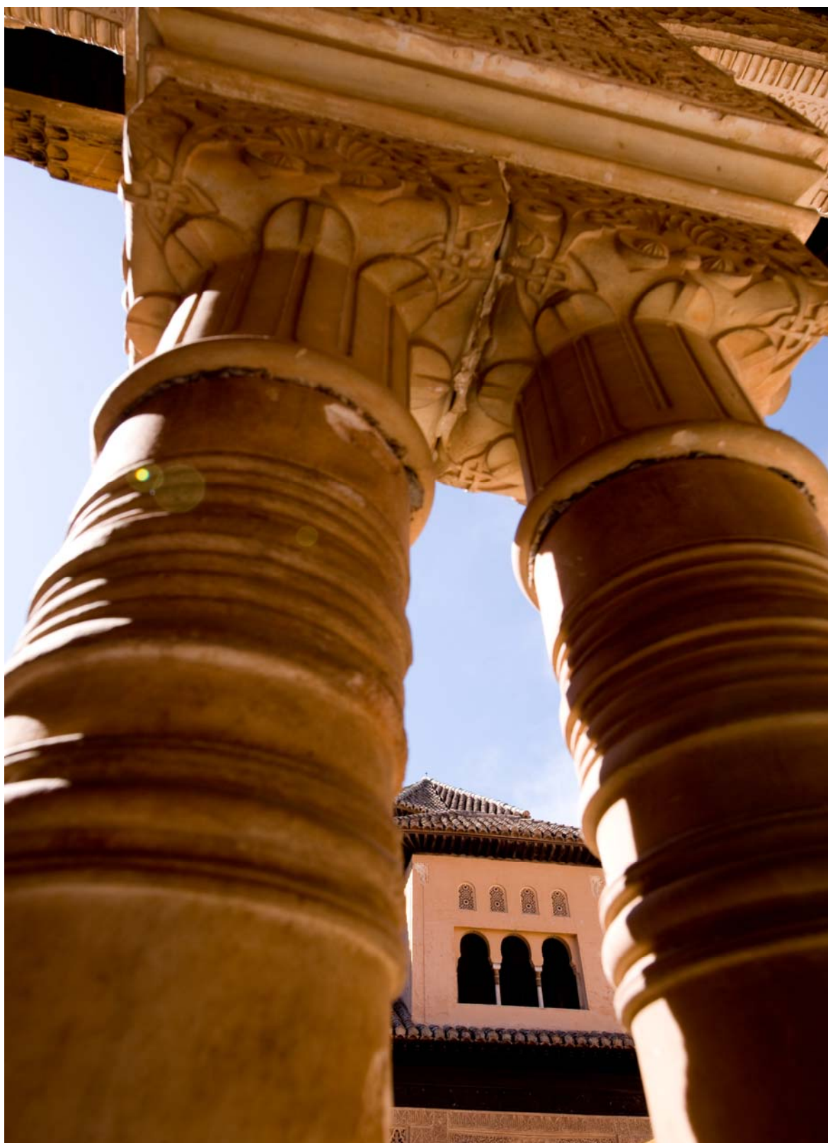
LÁMINA 85: DETALLE DE LAS COLUMNAS DEL MIRADOR ALTO DE ABENCERRAJES. FOTOS: FIESTAS MORENO, M.
