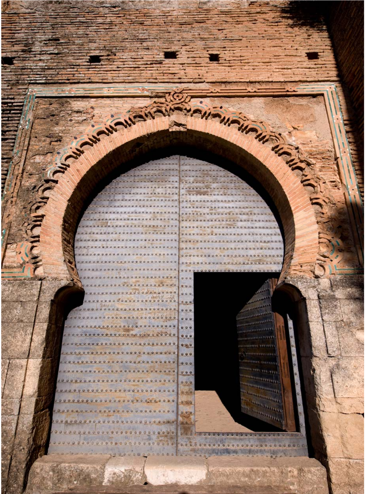
LÁMINA 2: FACHADA PRINCIPAL DE LA PUERTA DE LAS ARMAS. FOTOS: FIESTAS MORENO, M.
