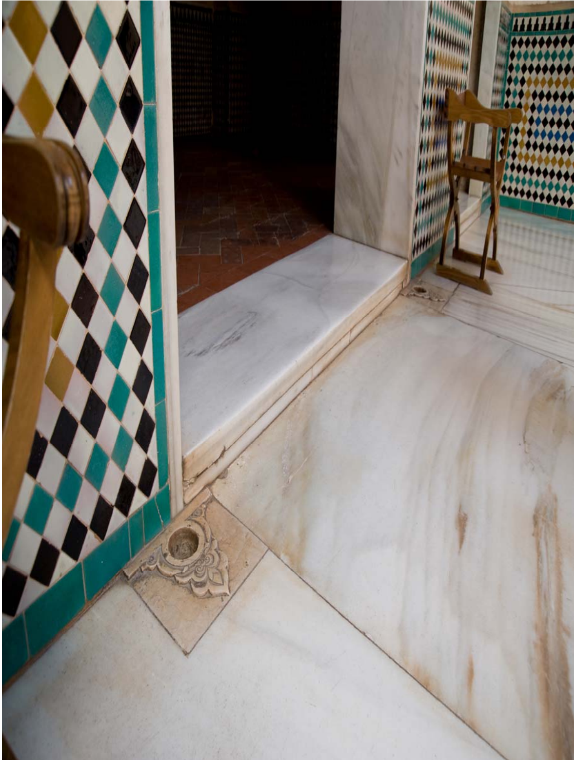
LÁMINA 42: PALACIO DE COMARES. DETALLE DE LA QUICIALERA DE LA PUERTA DE LA SALA DE LA JUSTICIA. FOTOS: FIESTAS MORENO, M.
