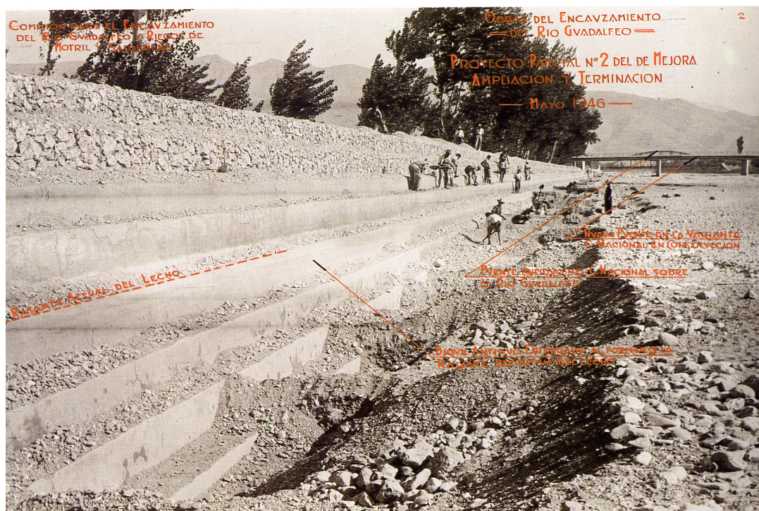
Figura 18. Obra de Encauzamiento del Río Guadalfeo en 1946
