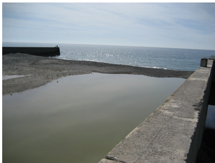
Figura 23. Estado actual de la desembocadura del río Guadalfeo
