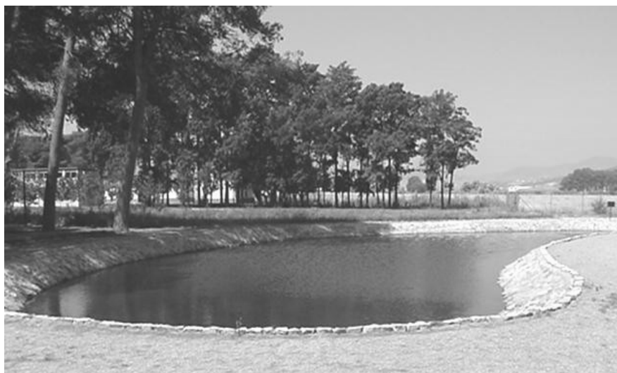
Figura 67. Lagunaje en la ‘Estación Experimental de Depuración no Convencional’ del CENTA en Carrión de los Céspedes, Huelva
