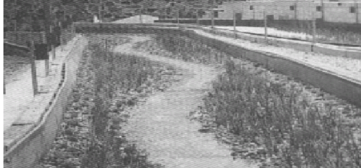
Figura 8. Canalización urbana con cauce meandriforme
