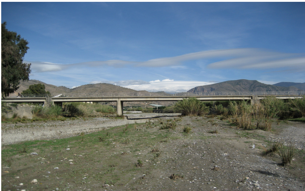
Figura 6. Río Guadalfeo tras la derivación de agua del Azud de Vélez, aguas abajo del embalse de Rules
