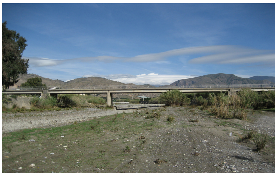
Figura 21. Encauzamiento del Río Guadalfeo en el delta
