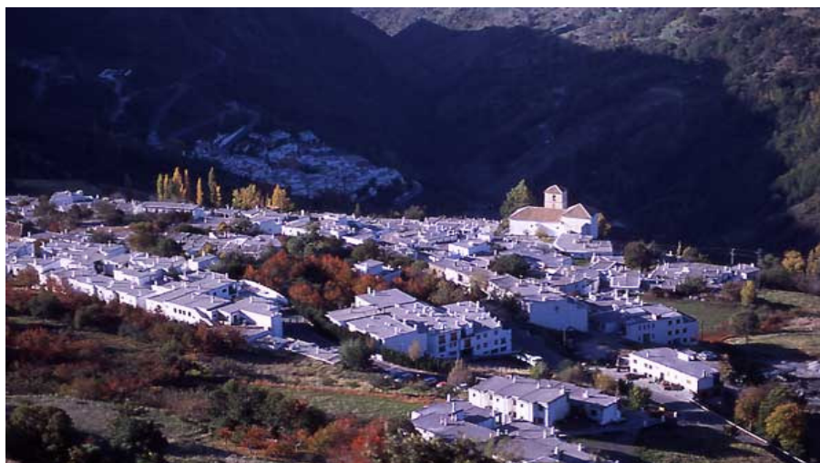
Figura 42. Vista aérea de Bubión, Alpujarra
