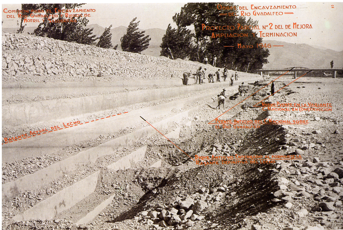
Figura 27. Encauzamiento del Río Guadalfeo
