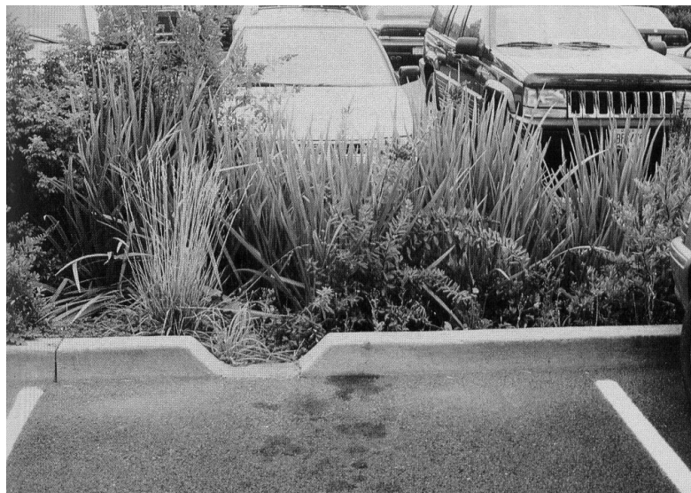
Figura 69. Zanja filtrante en un aparcamiento de Oregón, E.E.U.U.
