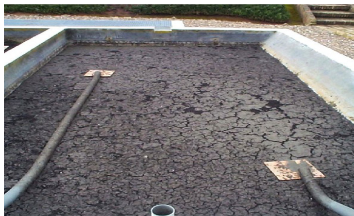
Figura 70. Lecho de Turba en la ‘Estación Experimental de Depuración no Convencional’ del CENTA en Carrión de los Céspedes, Huelva
