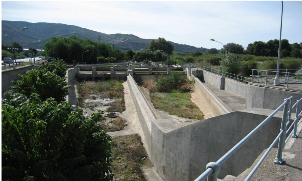
Figura 5. Derivación de agua para la agricultura en el Azud de Vélez de Benaudalla, aguas abajo del embalse de Rules
