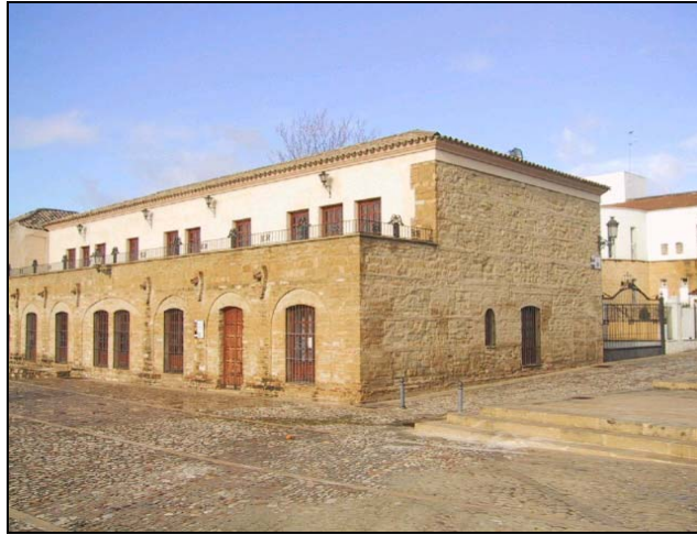
IMAGEN ACTUAL DE LA LLAMADA “CASA DEL REY” EN ARJONA
