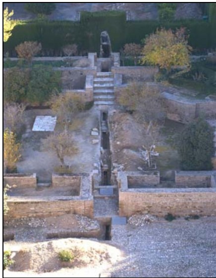
SISTEMA DE CANALIZACIÓN EN LA ALHAMBRA
