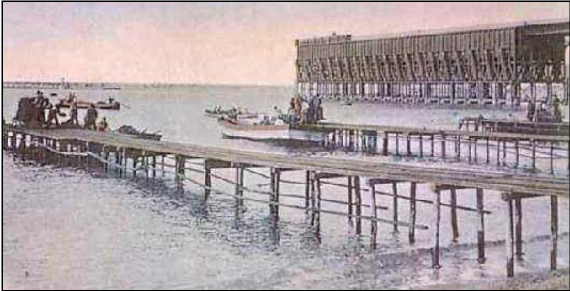
Figura 3.2 Cargadero mineral de Almería, icono del pasado minero de la provincia.
