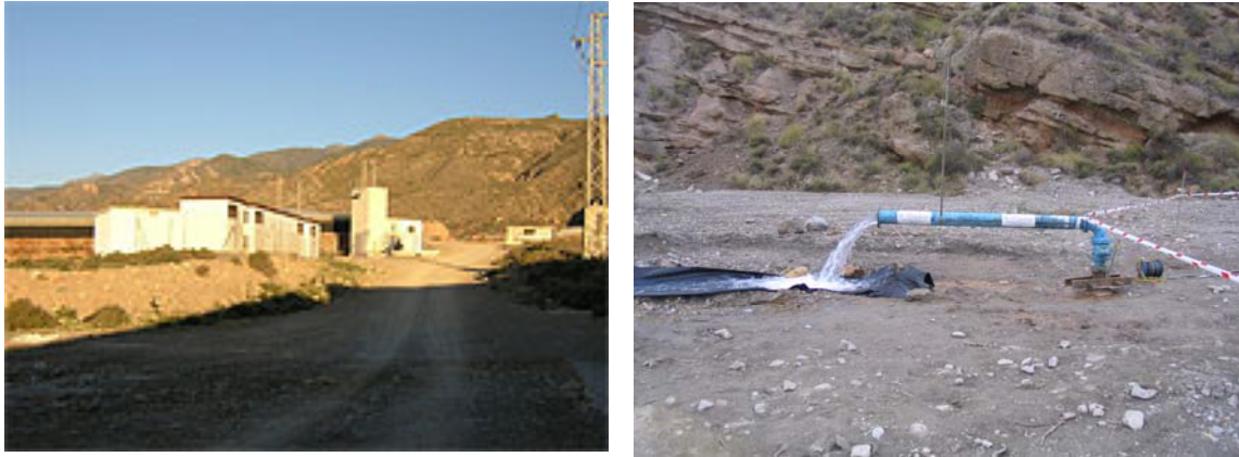
Figura 7.1 Fotografías de los Pozos de Bernal en el Campo de Dalías y de la prueba de bombeo de una captación subterránea en Almería. Fuente: Diputación Provincial de Almería.
