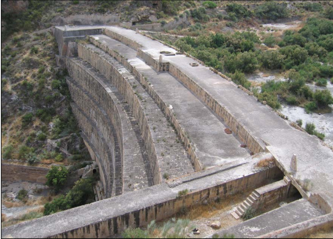
Figura 5.1 Foto de la presa del Pantano de Isabel II en Níjar-Almería. Fuente: elaboración propia.
