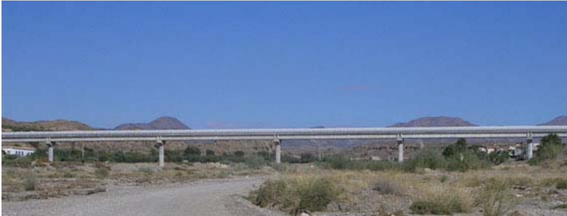
Figura 7.6 Fotografía de la conducción del trasvase del Negratín-Almanzora. Año 2009. Fuente: elaboración propia.
