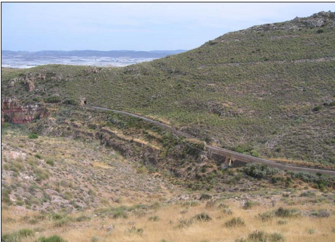
Figura 5.3 Foto del canal que transportaba el agua hacia el Campo de Níjar-Almería. Fuente: elaboración propia.
