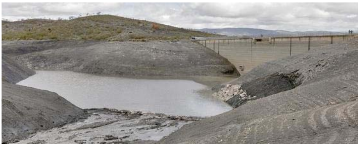
Figura 7.4 Fotografías de la Presa de el Castañar-Fiñana. Año 2010. Fuente: Elaboración propia .
