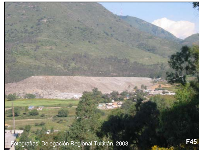
Fotografía 42-45 Depósitos de residuos sólidos saneados
