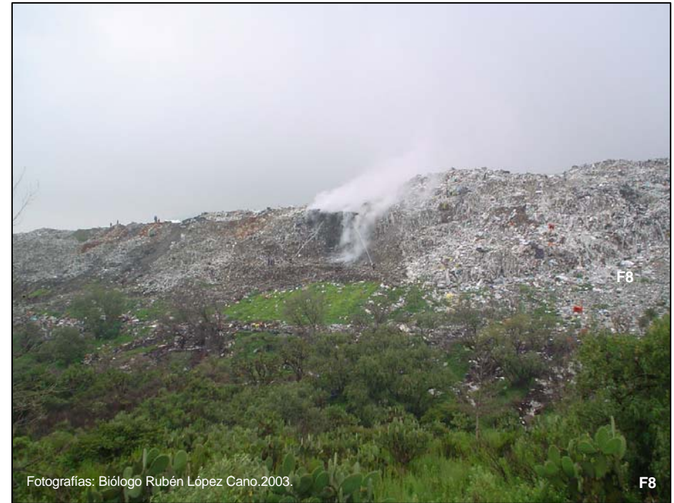
Fotografía 8. Problema de lixiviados y contaminación de corrientes superficiales
