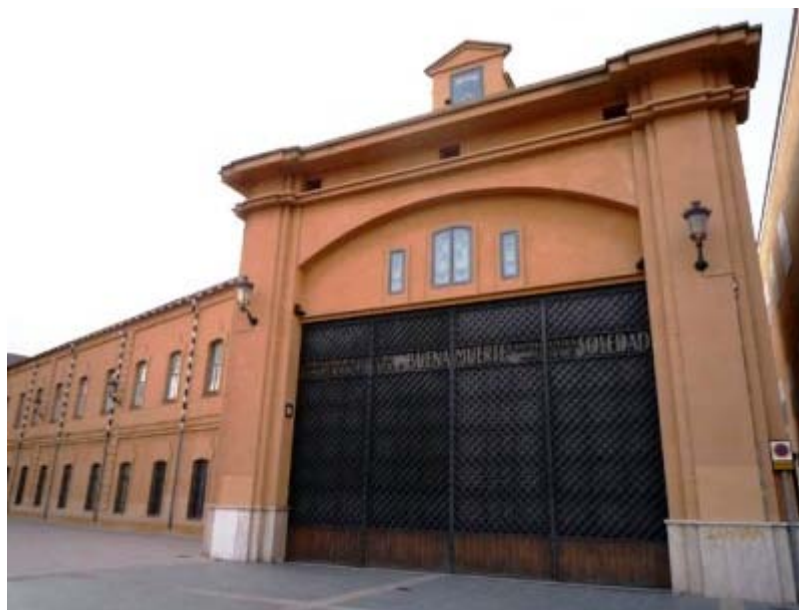
34. Casa de los tronos de la Congregación de Mena (Brisset 2011).
