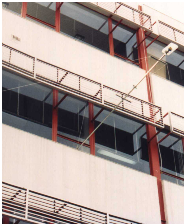
Figura 2.1. Sistema de captación de aerosoles.
