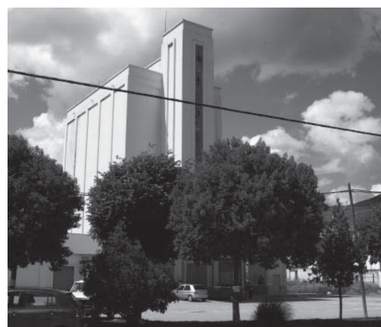
Silo. Borde urbano del Padul con Las Viñas. Arquitectura singular de almacenaje de grano, característico de estos pueblos agrícolas pequeños.
