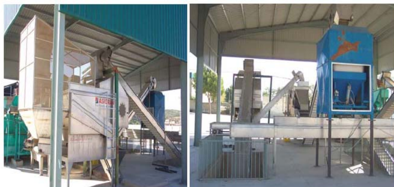
Figura. Instalación para el lavado y pesado de la aceituna.
