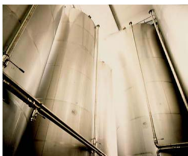
Figura. Bodega con depósitos de almacenamiento de aceite
