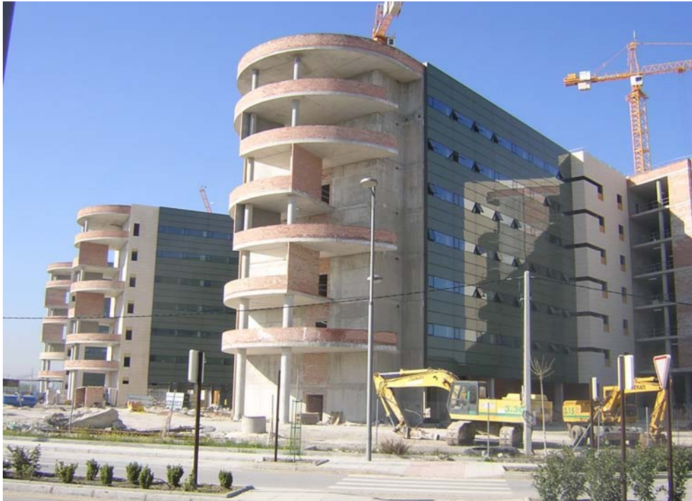
Figura A.13.2. Construcción del nuevo Hospital Universitario San Cecilio (Marzo 2006).
