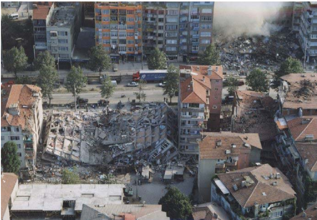
Figura 1.3. Edificios destruidos en un barrio en el que los más antiguos resistieron. Turquía 1999.
