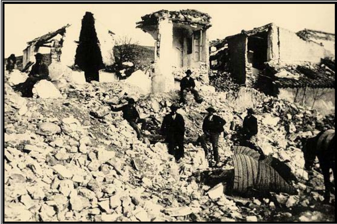
Figura 2.1. Colapso de construcciones en Arenas del Rey (Granada), población completamente destruida por el terremoto de 1884). El emplazamiento del pueblo se desplazó a medio kilómetro del antiguo.
