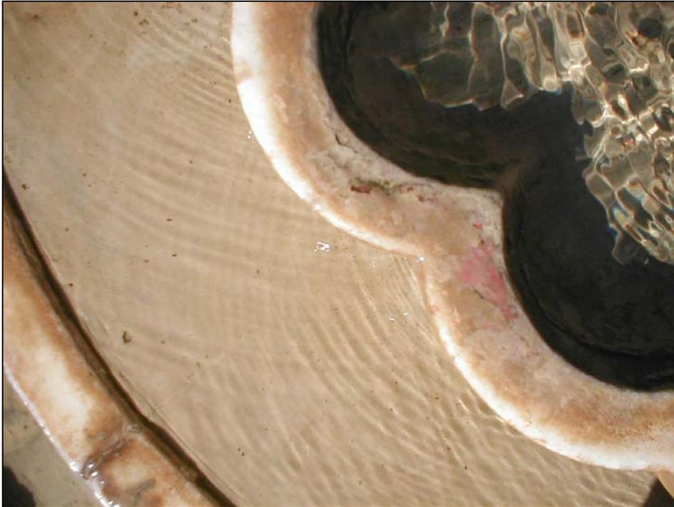
Fig. 1.3.2- Borde de una fuente del Generalife, en la Alhambra, donde se puede observar el parecido aspecto de las costras estromatolíticas con el sustrato original.
