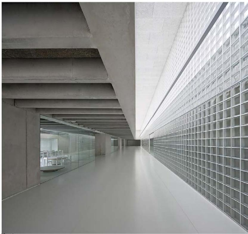
Constructivamente el proyecto se caracteriza por la utilización de elementos prefabricados de hormigón.
