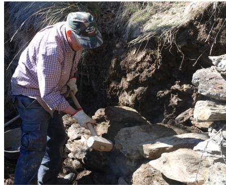
Figs.62-63. Construcción de la base de la acequia a modo de laja “entraconá” y construcción de un balate (L. Delgado Anés)
