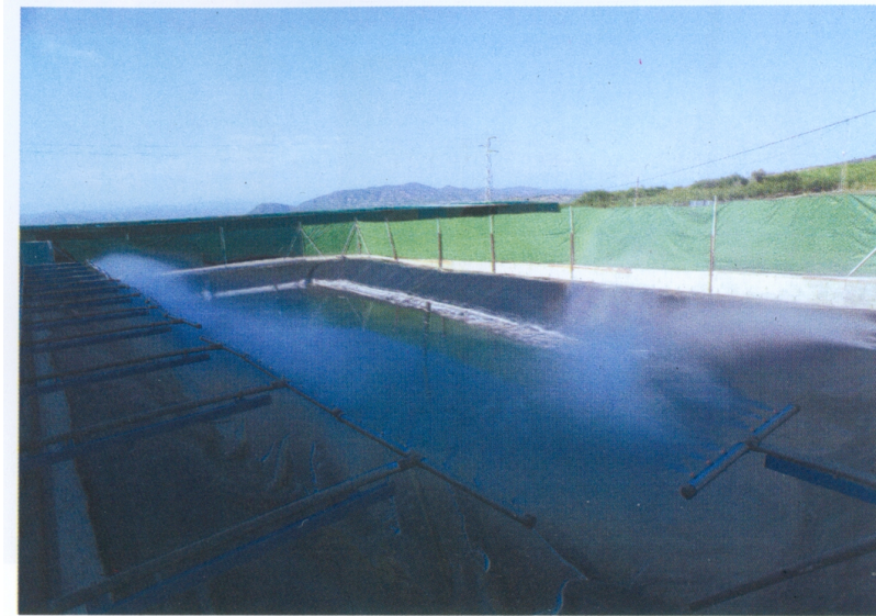
Figura I.12. Balsa de almacenamiento con sistema de evaporación forzada mediante aspersión.
