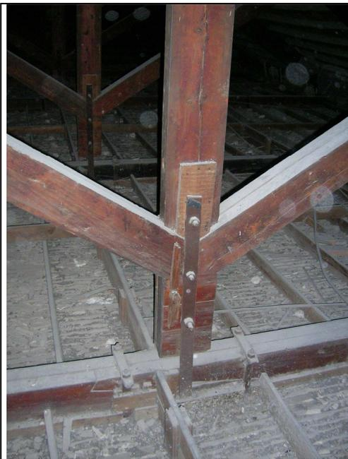
3.2.1.e. Apoyo del pendolón central en el tirante, mediante cinchos de hierro. Apoyo del armazón del cielo raso de cañizo sobre las cerchas.
