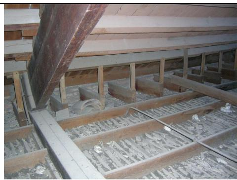
3.2.1.k. Detalle interior del apoyo de la cercha y sujeción del armazón de madera y cañizo que soporta el cielo raso de yeso.
