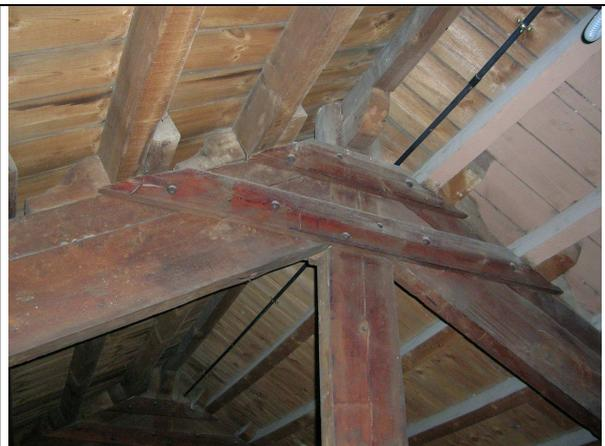
3.2.1.f. Sujeción de las correas a los pares mediante egijones.
