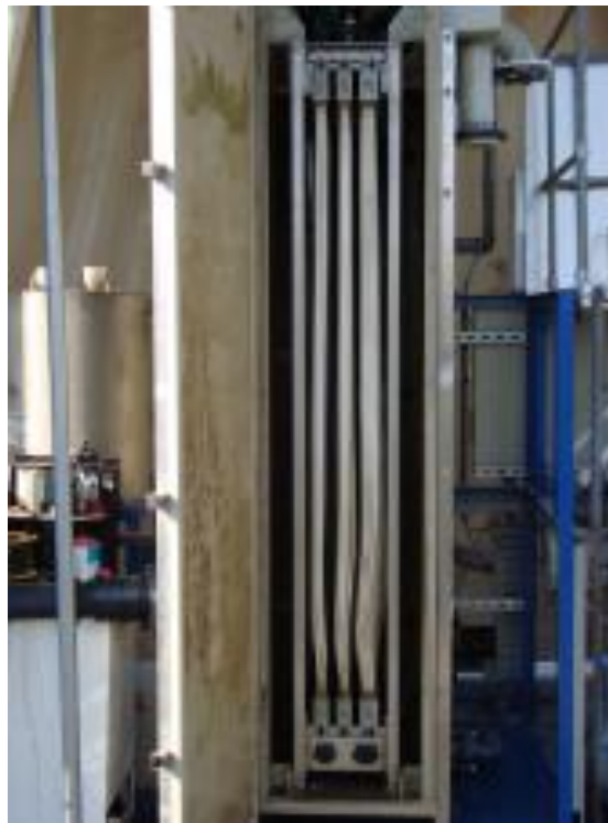
Figura 3.9. Interior del MBR de la instalación de UF.
