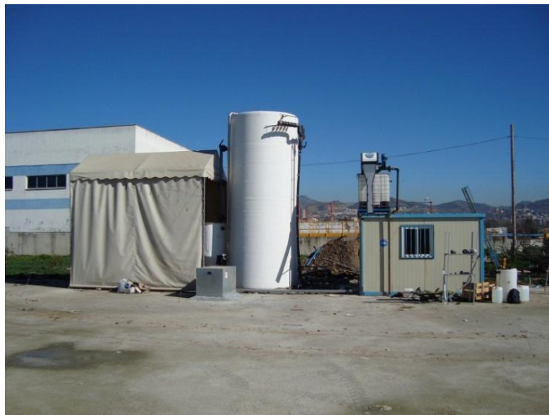
Figura 3.6. Visión general de la instalación de UF.
