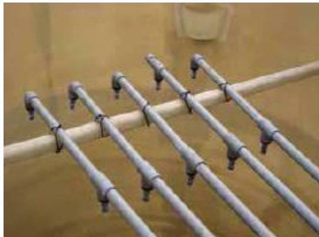
Figura 3.8. Sistema de pulverización de la instalación de UF.
