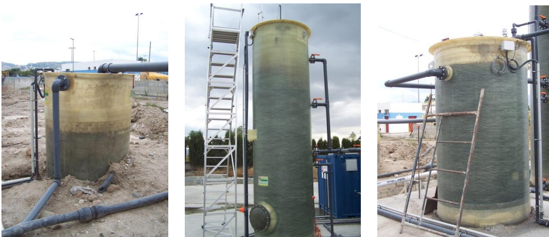
Figura 3.2. Biorreactor anóxico (izquierda), aireado (centro) y MBR (derecha) de la instalación de MF.
