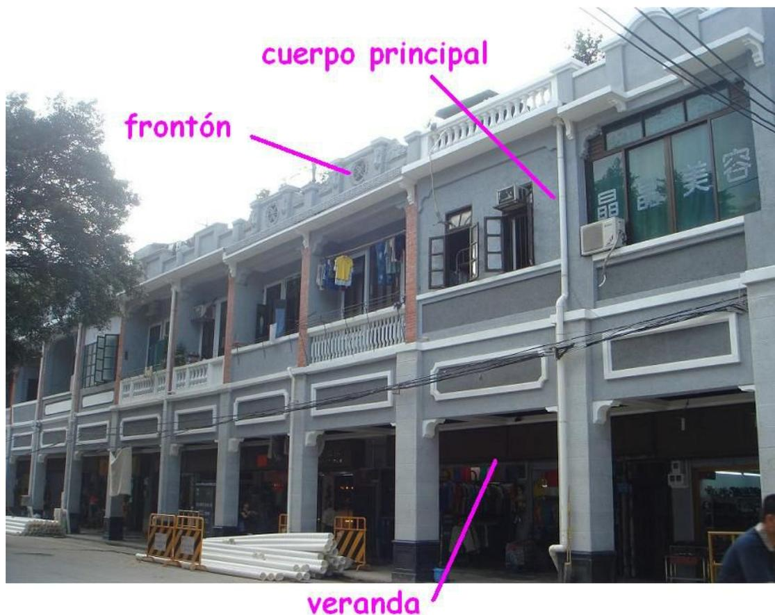
Figura 4-10 *La composición del edificio del qilou*
