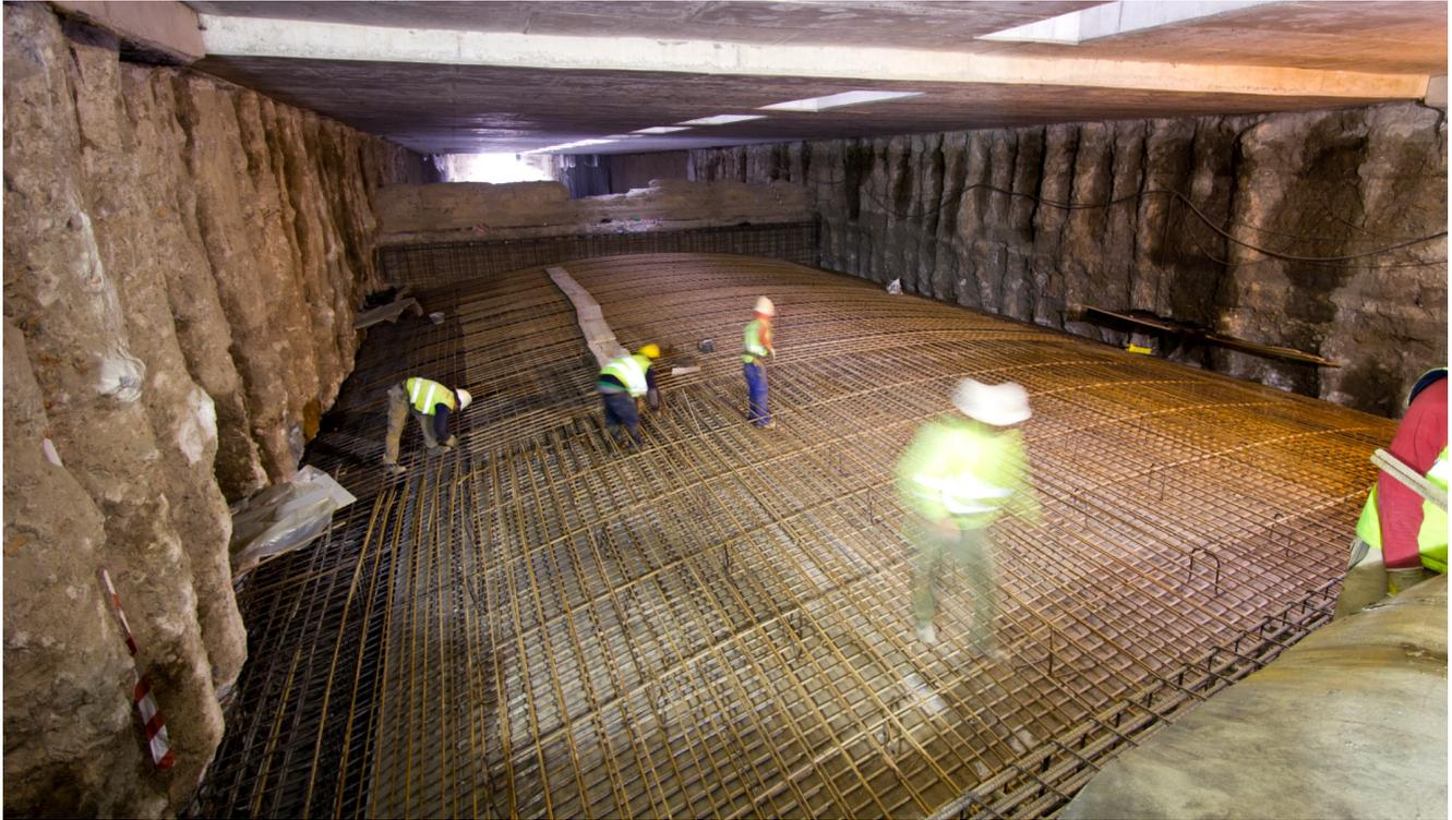
Figura 6. El terreno natural actúa de encofrado de la bóveda de sujeción del Albercón
