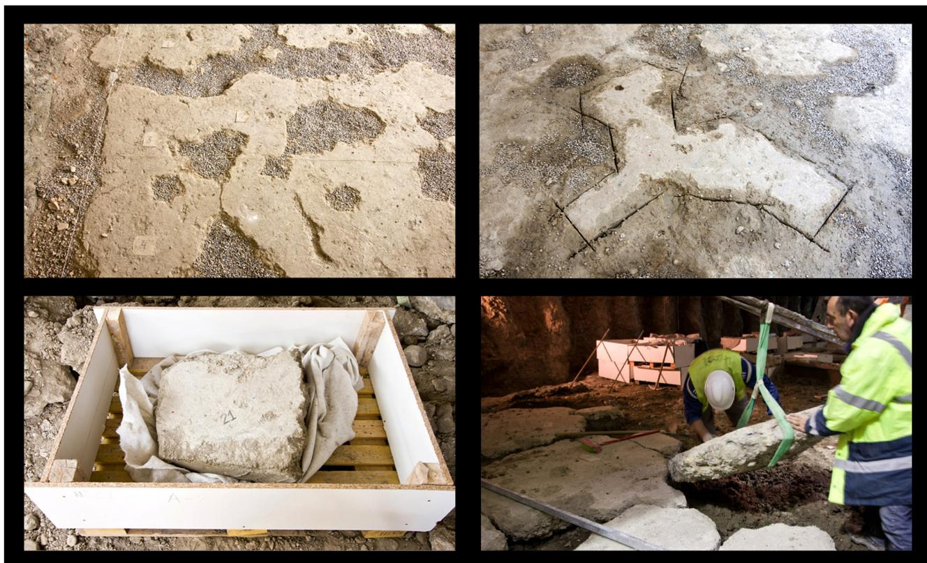
Figura 9. Catalogación y tratamiento de los fragmentos originales del vaso del Albercón.
