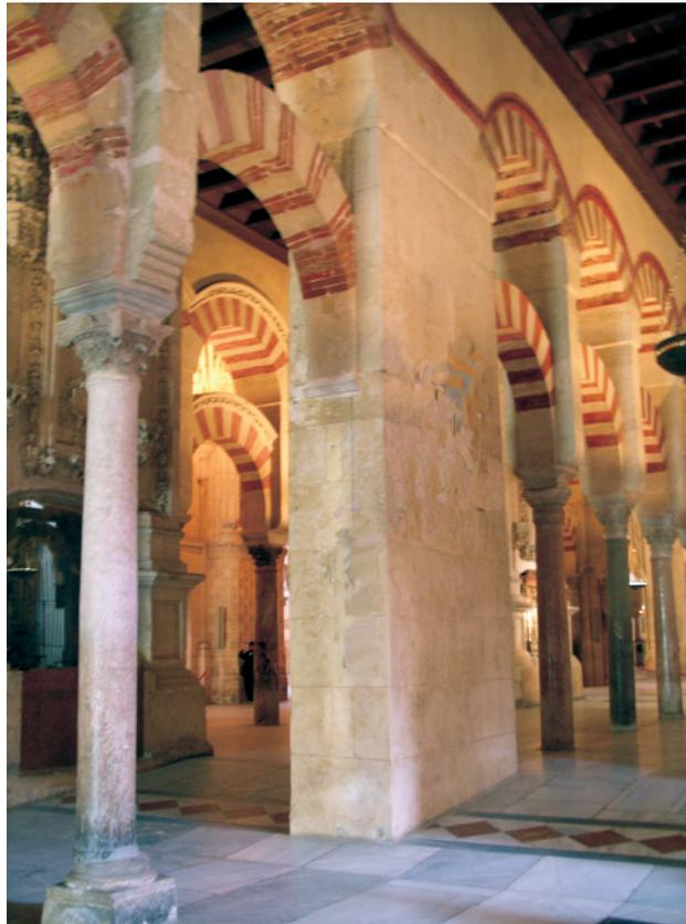
Lám. III. Contrafuerte de la mezquita de ‘Abd al-Raḥmān I. El muro de la *qibla* demolido está señalado en la solería (Foto P. Marinetto Sánchez).
