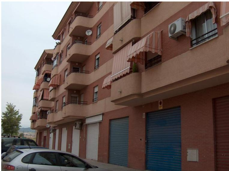
*Figura 9: Edificio de tipología RC3.2 con piso débil en plant baja, en calle Rosa Chacel.*
