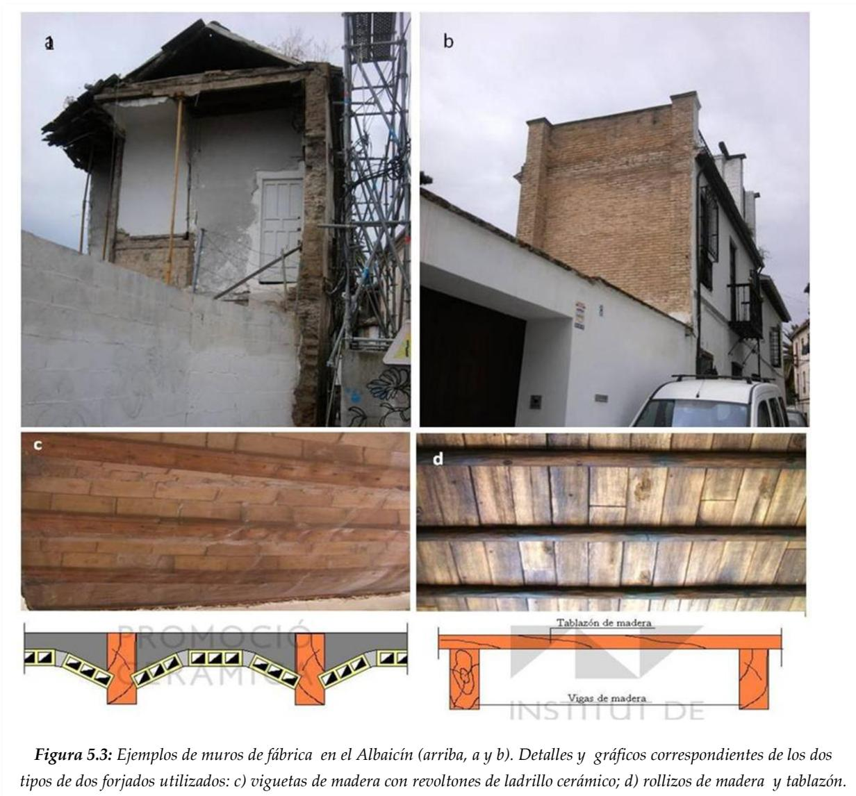
**Figura 5.3:** Ejemplos de muros de fábrica en el Albaicín (arriba, a y b). Detalles y gráficos correspondientes de los dos tipos de dos forjados utilizados: c) viguetas de madera con revoltones de ladrillo cerámico; d) rollizos de madera y tablazón.
