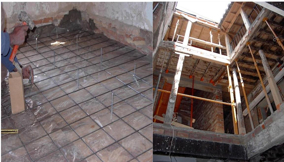
*Figura 5.7: Refuerzo de forjados de madera (izq.) y rehabilitación de edificio de muros de fábrica y forjados de madera. Archivo fotográfico Programa Elvira-Goméz (Gerencia de Urbanismo de Granada).*
