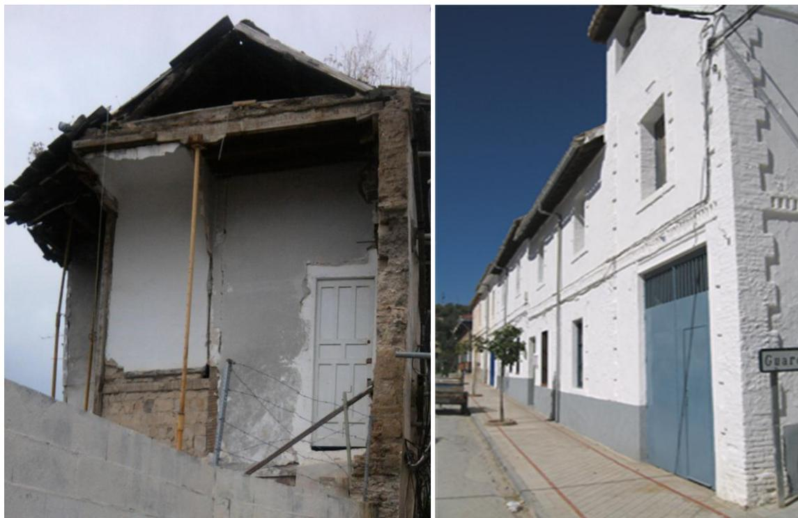
**Figura 4.18:** Tipología de fábrica de ladrillo y forjados de madera. Izq.: sin reforzar (Albaicín, Granada). Dcha.: con refuerzos en las esquinas y conexiones entre elementos horizontales y verticales (Arenas del Rey, Granada)
