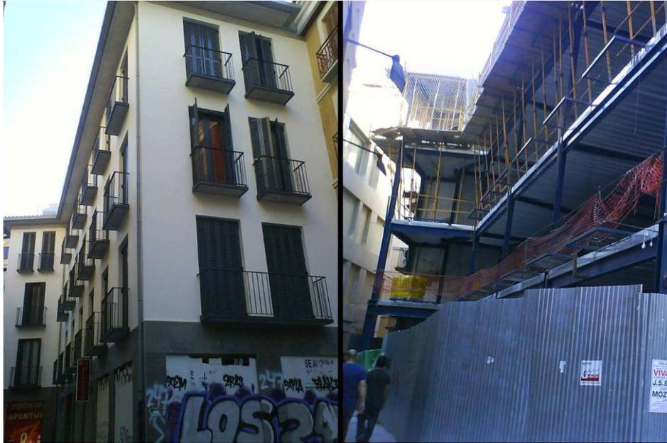
Figura 10: Edificio de tipología S2 de estructura metálica con forjados de chapa cloaborante, en calle Montereros.
