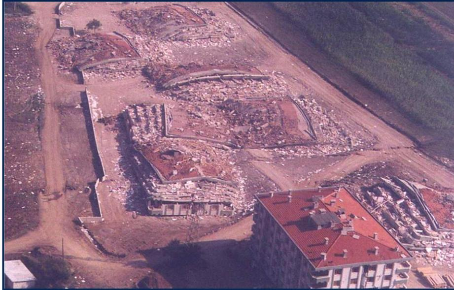
*Figura 4.11: Área residencial con 7 bloques de apartamentos, atravesada por la falla del sismo de Izmit, Turquía, 1999 (Mw= 7.6 USGS.). Desplazamiento lateral: 260cm*
