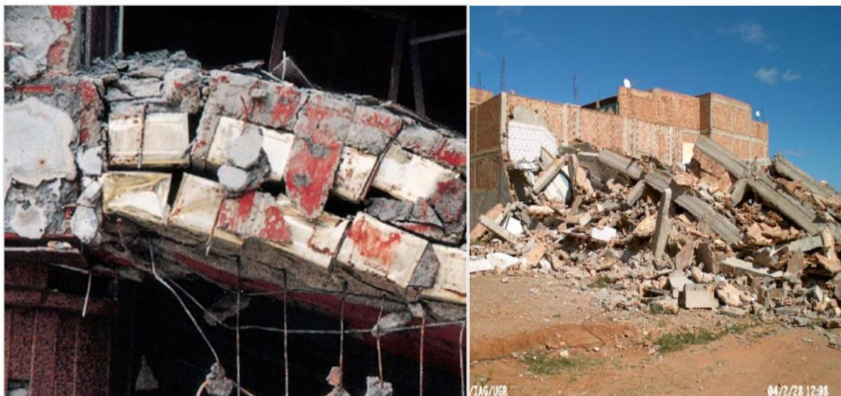
*Figura 4.26: Ejemplos de mala ejecución. Izq: uso de bidones de aceite para aligerar el forjado (Taiwan, 1999). Fuente: Munich Re.; Drcha: estructura de frágil elaborada con materiales de mala calidad y ejecución deficiente (Alhucemas, 2004)*
