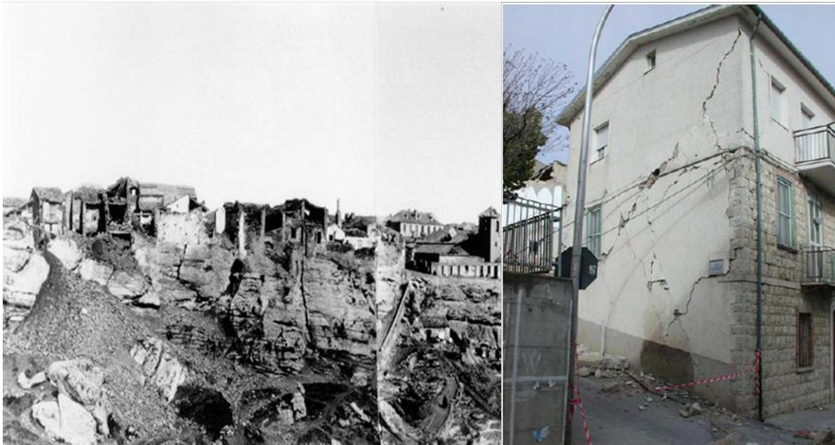
Figura 4.9: Izquierda: daños en el tajo de Alhama de Granada (Terremoto de 1884); Derecha: daños en un edificio situado en pendiente en la localidad de San Giuliano di Puglia (Terremoto de Molise de 2002).
