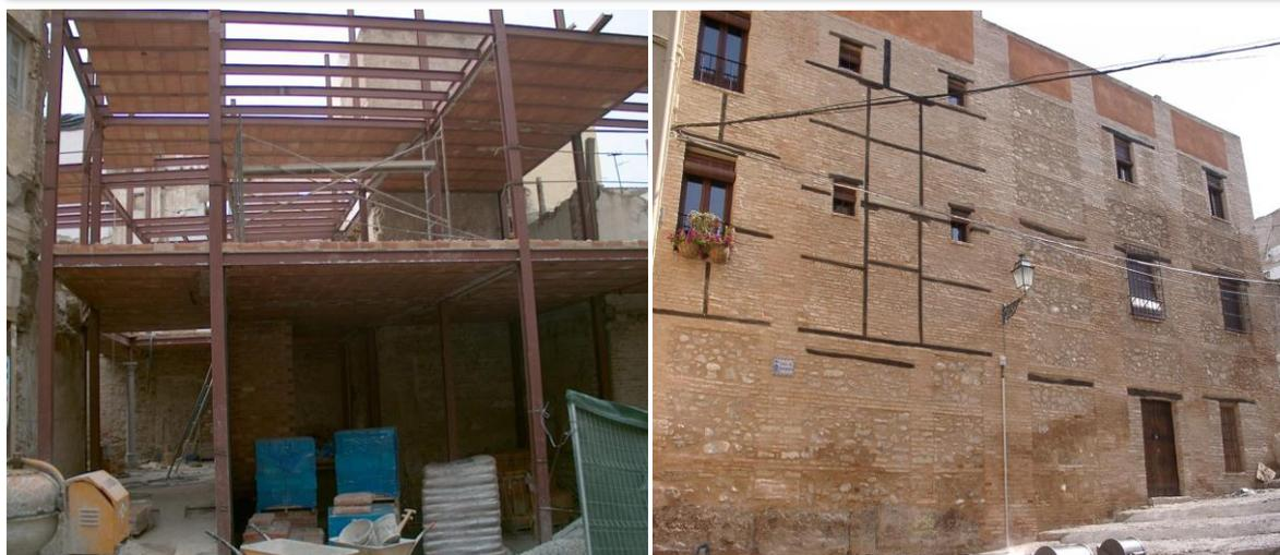
*Figura 5.8: Reconstrucción de edificio en C/ Horno de la Merced utilizando estructura metálica. En este caso se ha conservado una de las fachadas (Dcha). Archivo fotográfico Programa Elvira-Goméz (Gerencia de Urbanismo).*
