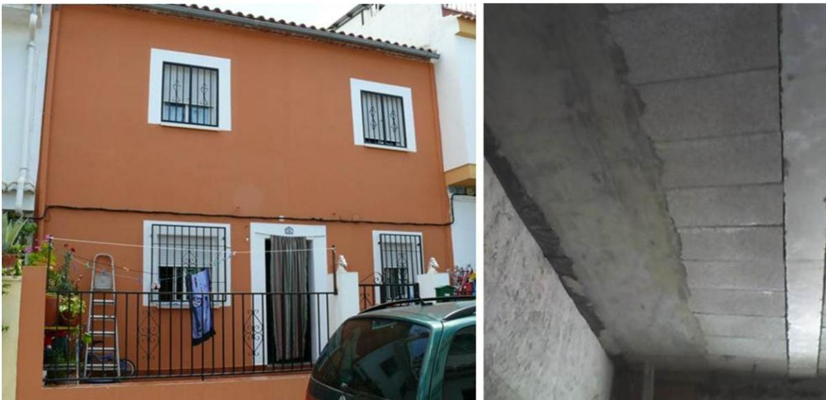
*Figura 5: Edificio de tipología M3.4 de muros de carga con forjados de hormigón armado en calle Bidasoa.*
