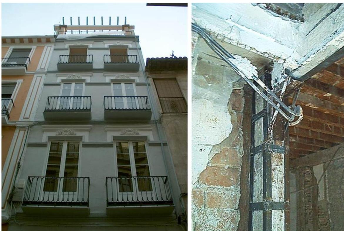
*Figura 7: Edificio de tipología M5 de mampostería reforzada con empresillado de pies derechos y vigas de madera mediante perfiles metálicos en calle Mesones.*
