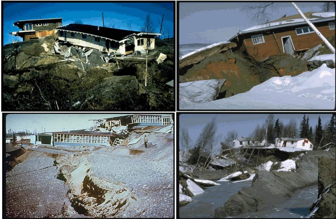
Figura 4.15: Deslizamiento provocado por el sismo de Alaska de 1964 y  $M=9.2$ .
