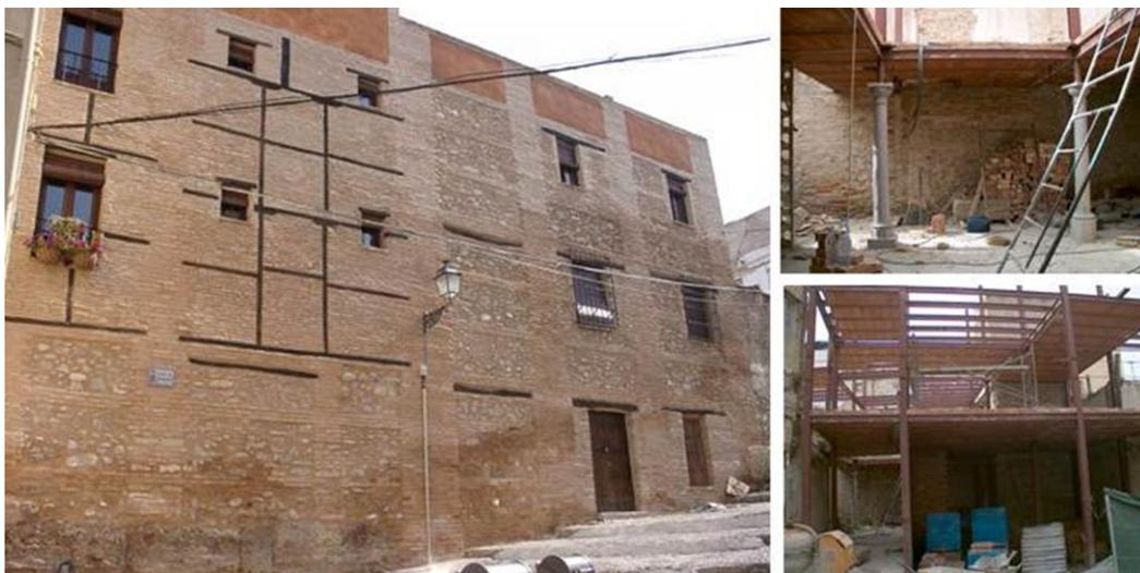
Figura 11: Edificio de tipología S3 de estructura metálica y muros de mampostería con entramado de madera.
