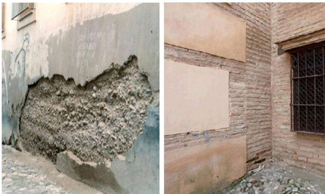
*Figura 2: Edificaciones de tapial en el Albaicín, empleando diferentes técnicas (Fuentes, 2010)*
