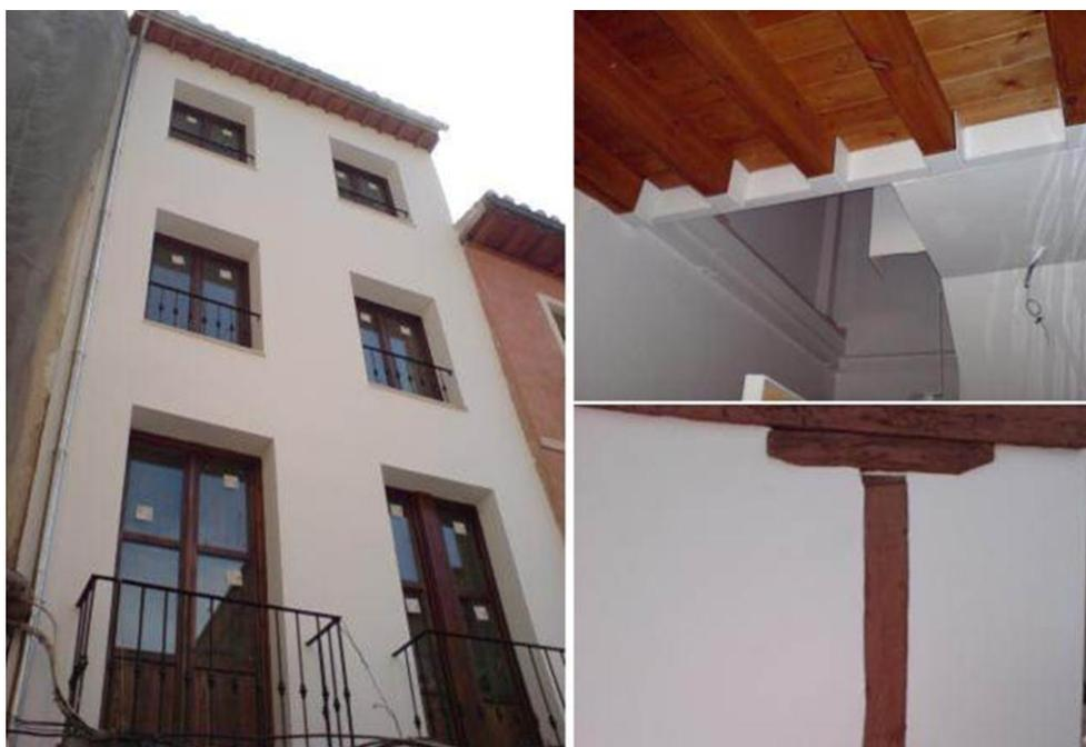
**Figura 6:** Edificio de tipología M4 ( mampostería reforzada con entramado de madera y perfiles metálicos) en C/Elvira.
