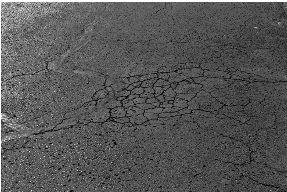
Figura 2. Ejemplo piel de cocodrilo Fuente: Asphalt institute
