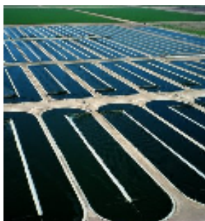
Figura 2.10 Reactor abierto tipo estanque
