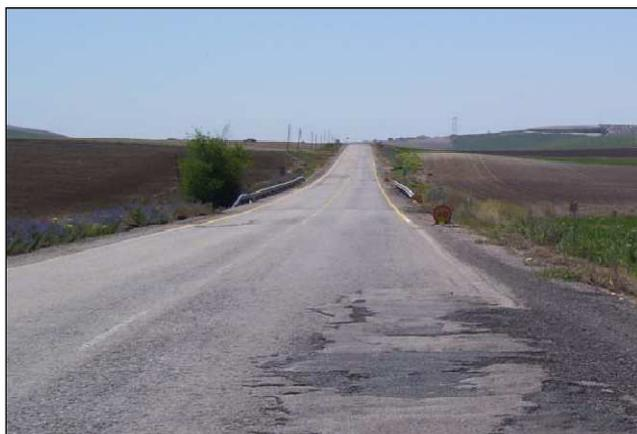
**Figura 13. Detalle del estado del firme antes de la actuación**
