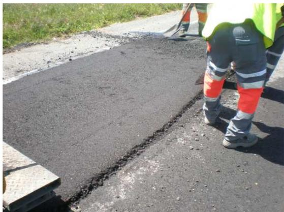
Figura 17. Extendido de la mezcla reciclada
