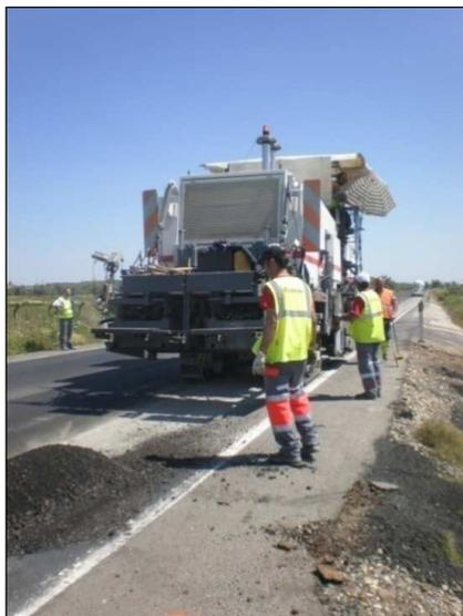
**Figura 16. Recicladora antes de comenzar los trabajos de rehabilitación en la A-472**
