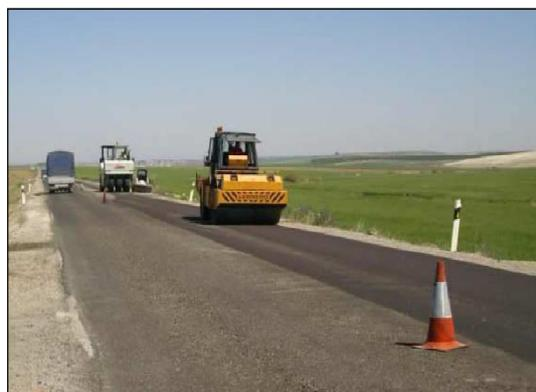
Figura 15. Compactación de la mezcla reciclada
