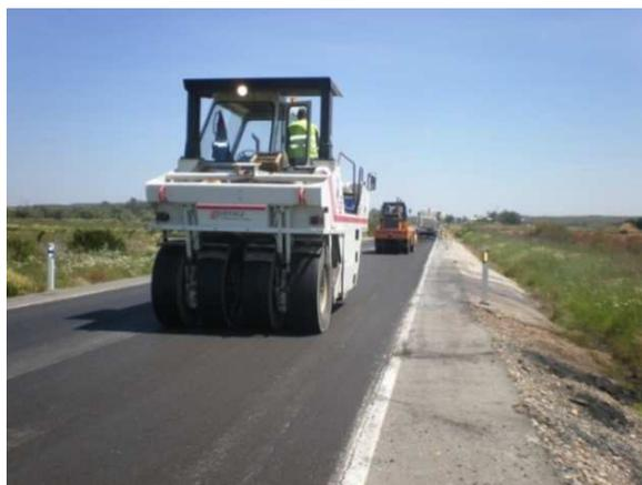
Figura 18. Compactación de la mezcla reciclada
