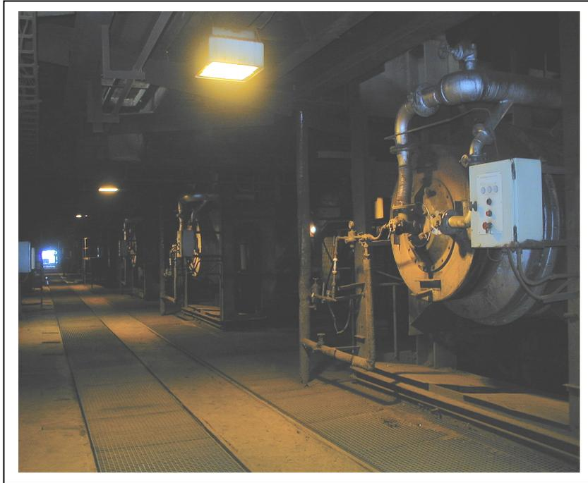
*Figura 3-8:- Vista de una Bateria de Cámaras de Combustión de los Hornos de Reducción*
