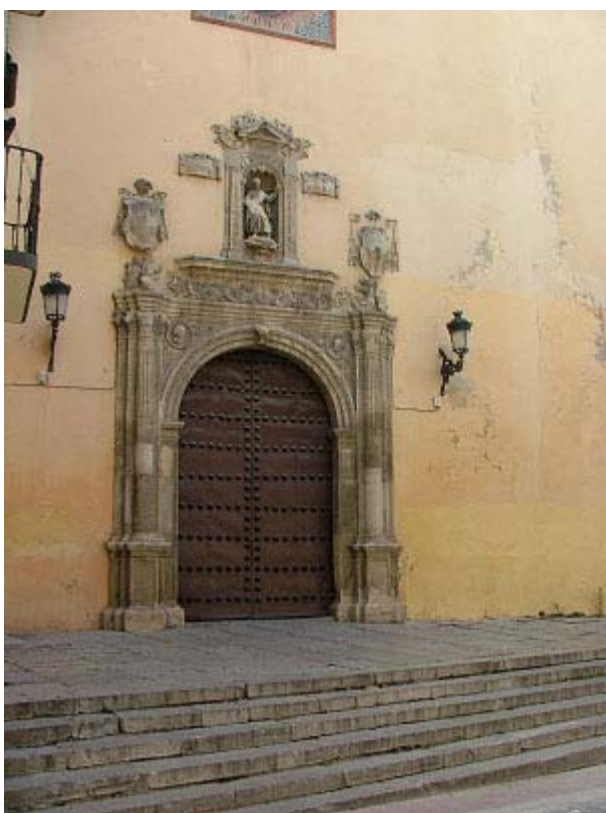
Fachada de San Matías, ante ella inmediata al acceso principal estuvo situado su cementerio en el siglo XVIII.
