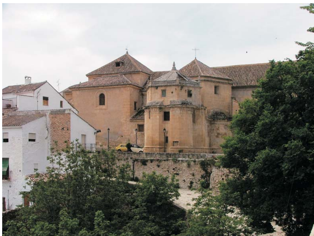
Vista del convento del carmen de Alhama de Granada.
