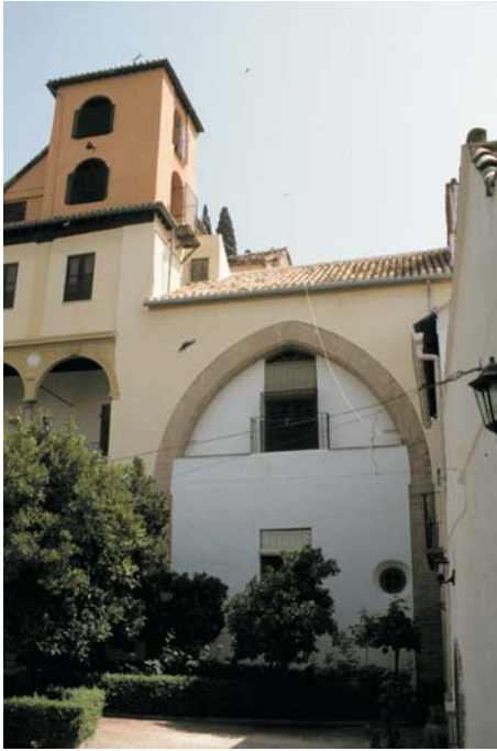
Arco toral que daba acceso a la antigua capilla mayor de la iglesia de Santa Catalina de Sena.
