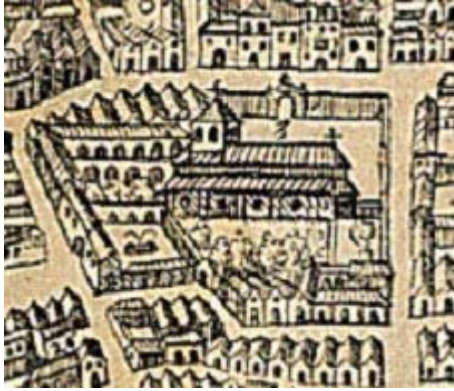
Convento de San Francisco Casa Grande. Detalle de la Plataforma de Vico.
