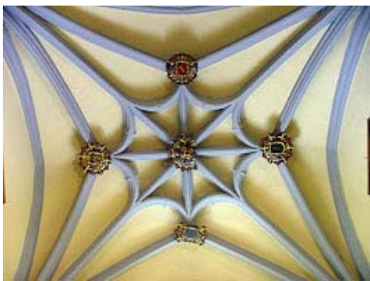
Capilla de Nuestra Señora de la Soledad. Detalles de la losa que cierra el acceso a al bóveda funeraria y la reja. Decoración heráldica de la bóveda de la capilla.
