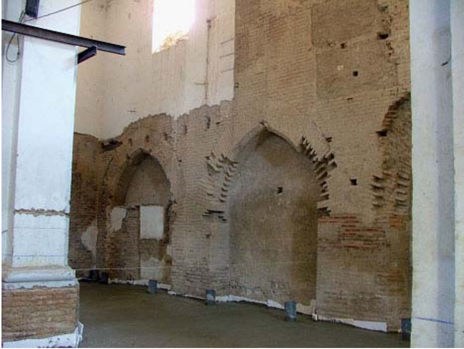
Interior de la iglesia de San Andrés durante sus recientes obras de restauración.
