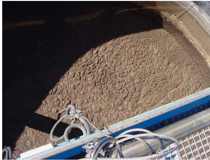
Figura 28. Vista del Reactor Biológico
